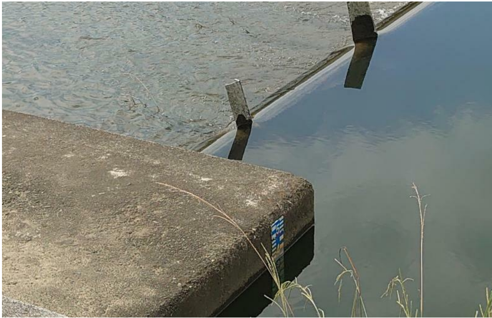
図2 可動堰上流側水位標がおよそ4を示している。水位1.4mのこと（筆者撮影）
