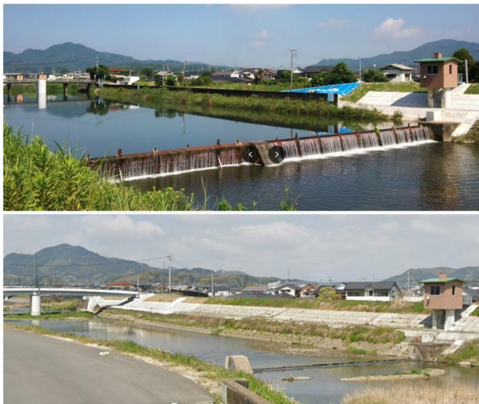
図3 可動堰の開閉に伴う河川の様子。上：閉、下：開（グーグルストリートビューから転載）
