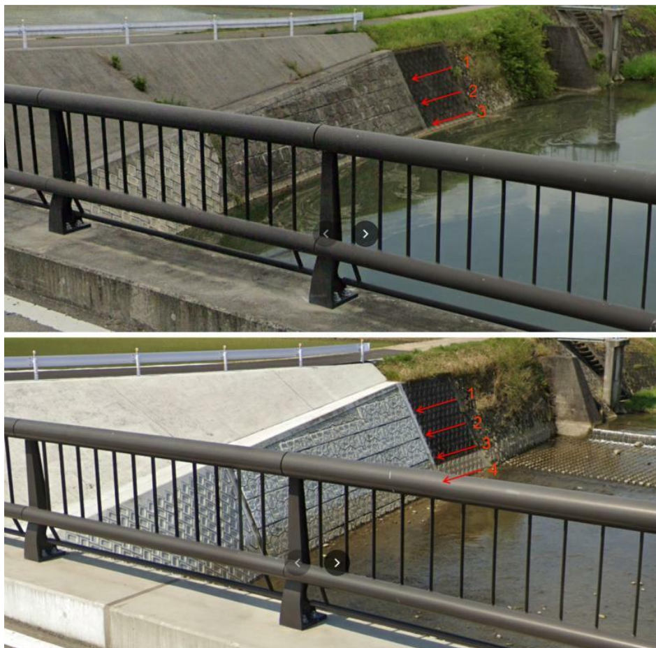
図4 可動堰の開閉に伴う水位上昇。上:閉、下:開(グーグルストリートビューから転載)
