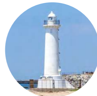
野間埼灯台 愛知県美浜町
