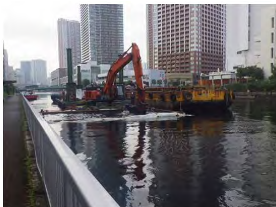
東京都港湾局「平成30年度芝浦運河汚泥しゅんせつ及び覆砂工事」
