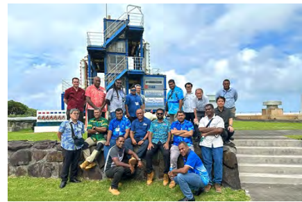
海洋温度差発電の国際協力 (フィジー共和国の技術者が久米島の 実証施設を視察) (沖縄県久米島町のウェブサイトより)
