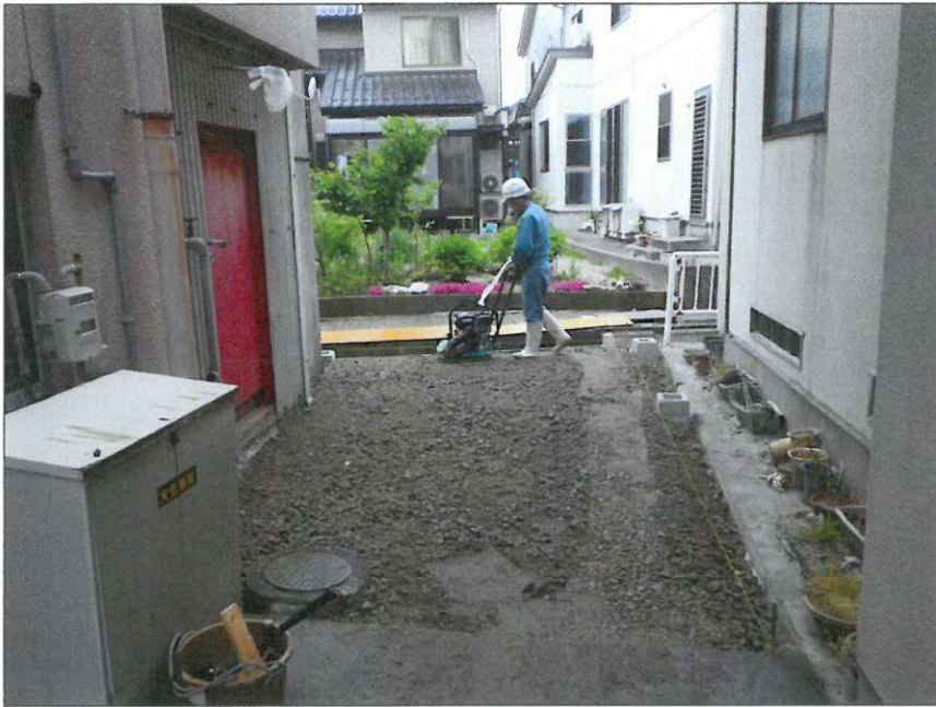
外部修理 門扉新設 施工状況 碎石敷き
