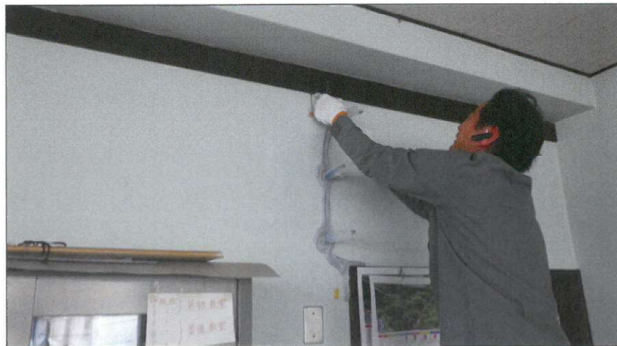
内部修理 壁クラック 施工状況 エポキシ注入
