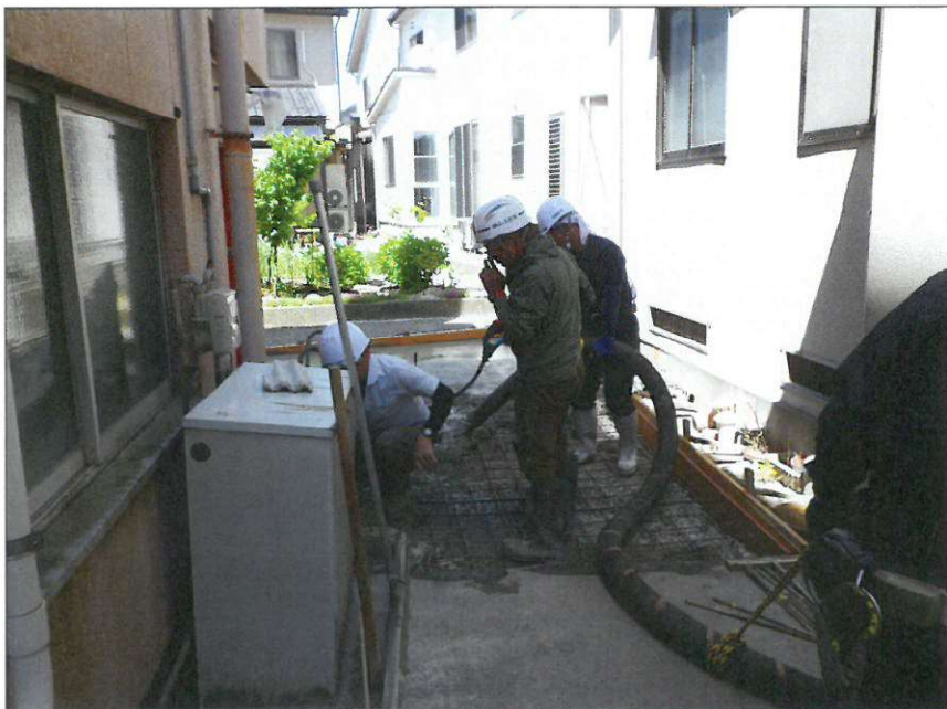
外部修理 門扉新設 コンクリート打設状況
