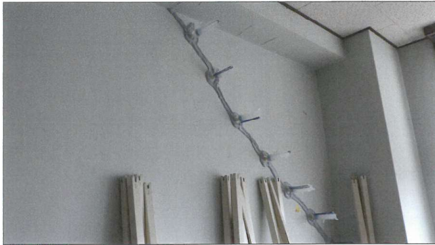
内部修理 壁クラック 施工状況 エポキシ注入
