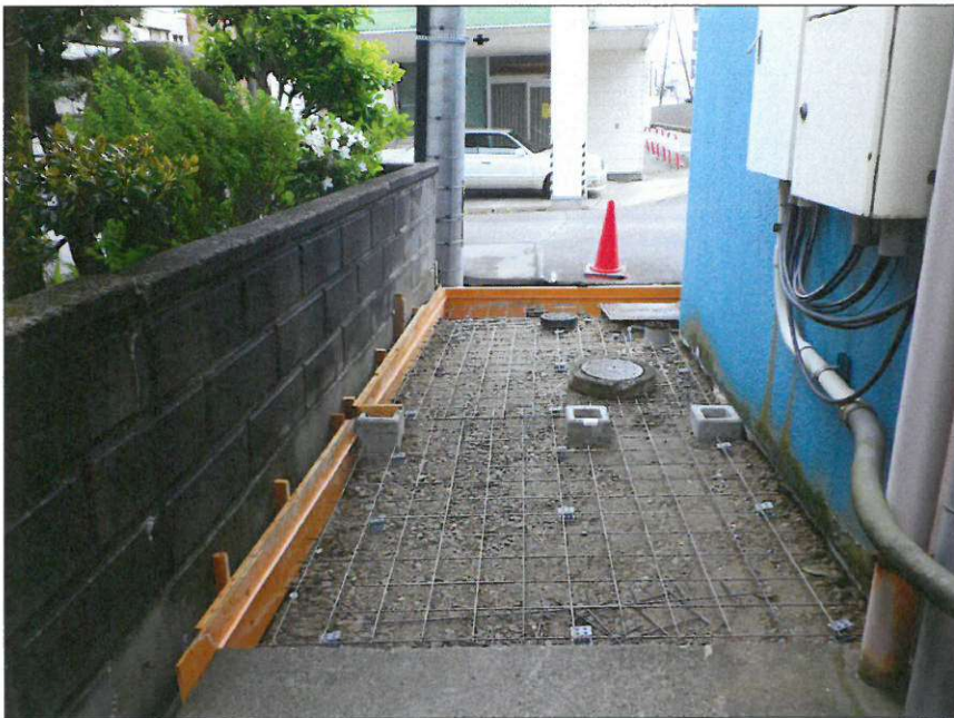
外部修理 門扉新設 ワイヤーメッシュ敷き
