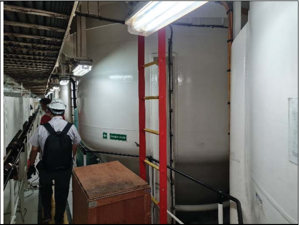
ドライ・バルク・タンク「セメント、 パライト、ベントナイト使用タンク」
