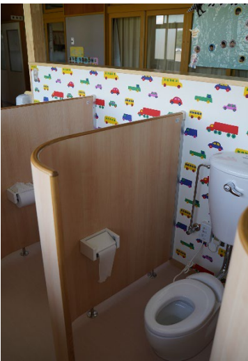
1階西側トイレ（大便器）
