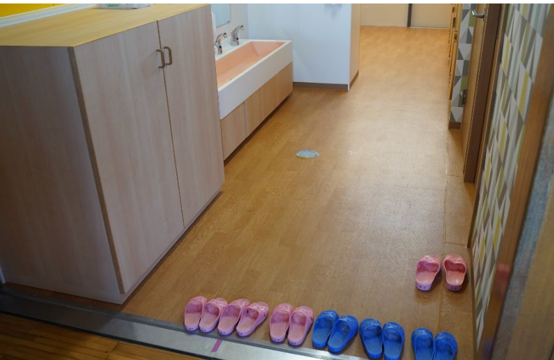
1階東側トイレ（段差解消箇所）
