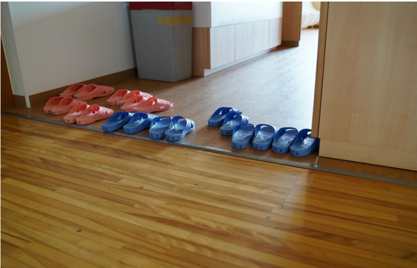
2階トイレ（段差解消箇所）
