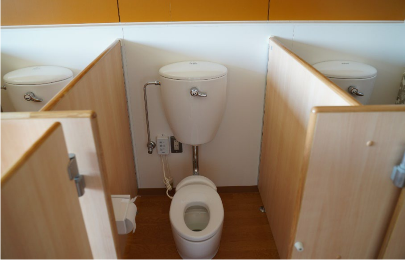
2階トイレ（大便器）
