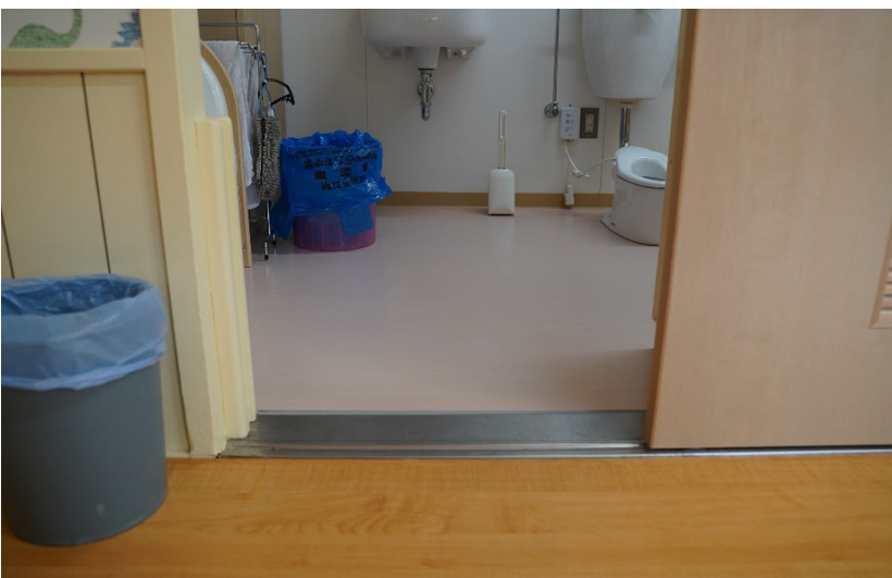
2歳児トイレ出入口（2歳児保育室Bからの段差解消箇所）
