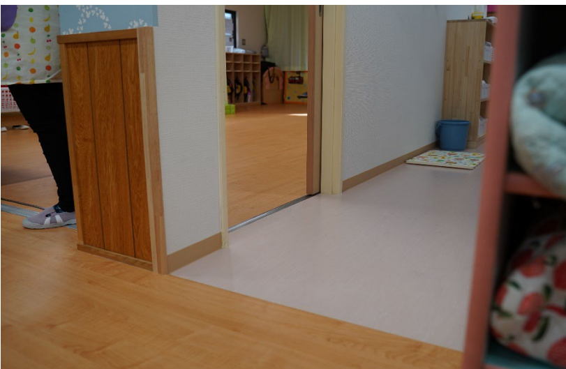
2歳児トイレ出入口（2歳児保育室Aからの段差解消箇所）
