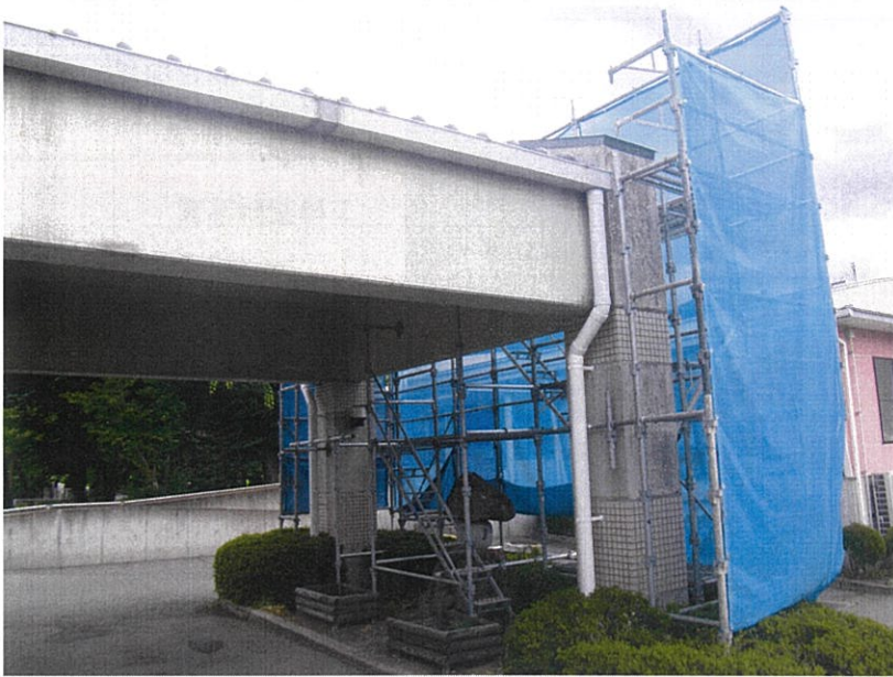
アザレアンさなだ 既存改修工事
