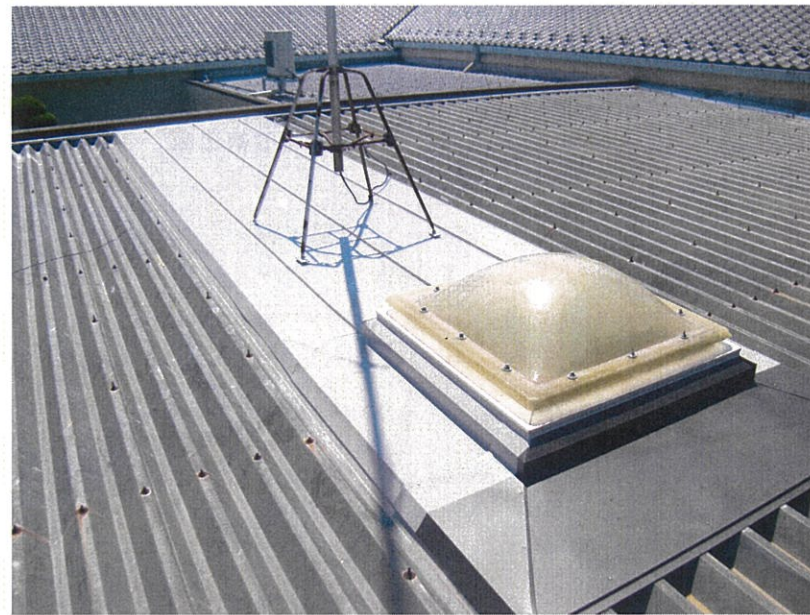
アザレアンさなだ 既存改修工事
