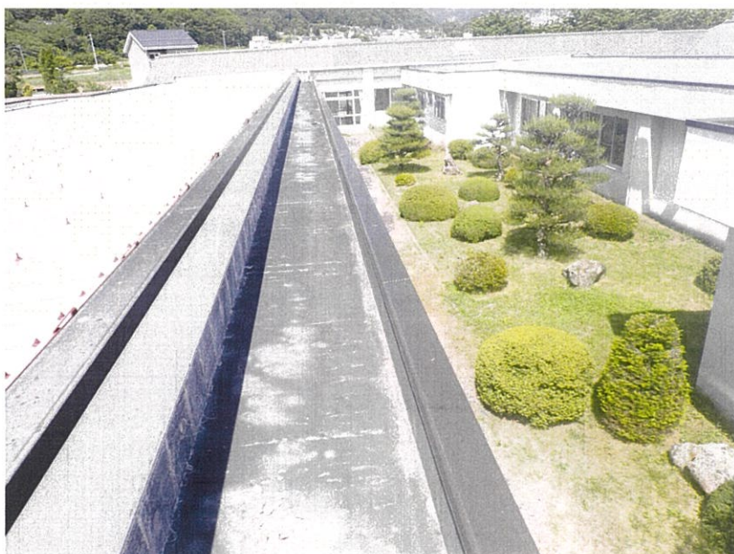
アザレアンさなだ 既存改修工事
