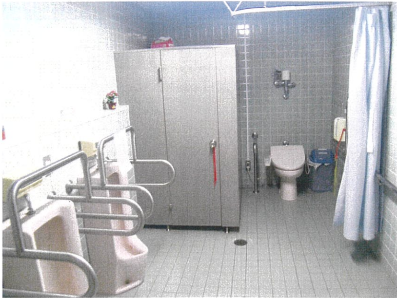
アザレアンさなだ 既存改修工事
