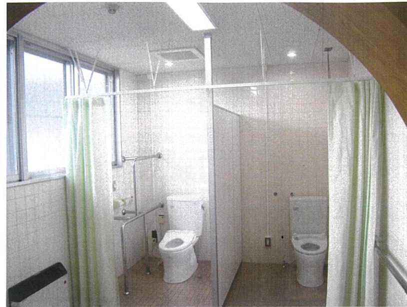
アザレアンさなだ 既存改修工事
