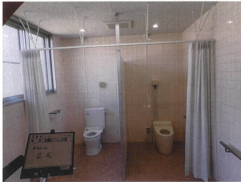
アザレアンさなだ 既存改修工事
