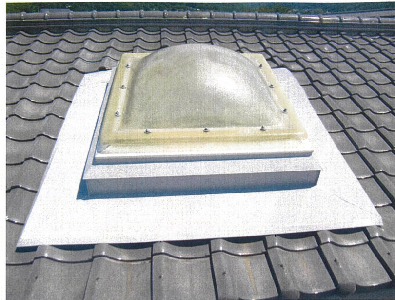
アザレアンさなだ 既存改修工事
