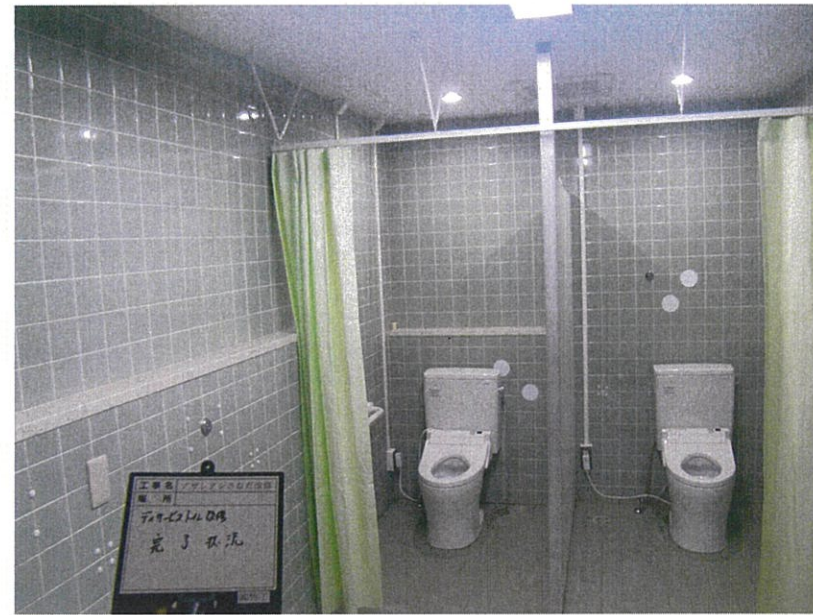
アザレアンさなだ 既存改修工事
