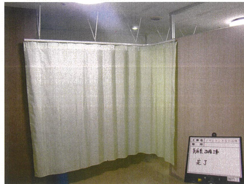
アザレアンさなだ 既存改修工事
