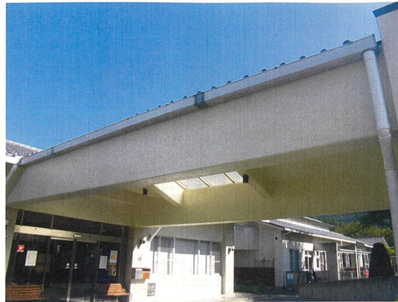
アザレアンさなだ 既存改修工事
