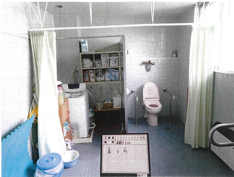
アザレアンさなだ 既存改修工事
