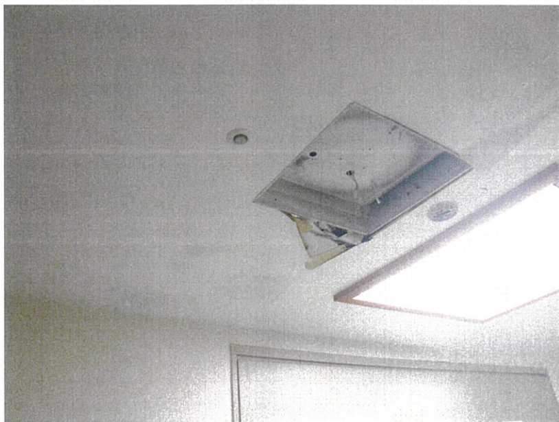
アザレアンさなだ 既存改修工事
