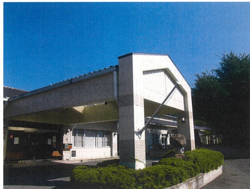
アザレアンさなだ 既存改修工事
