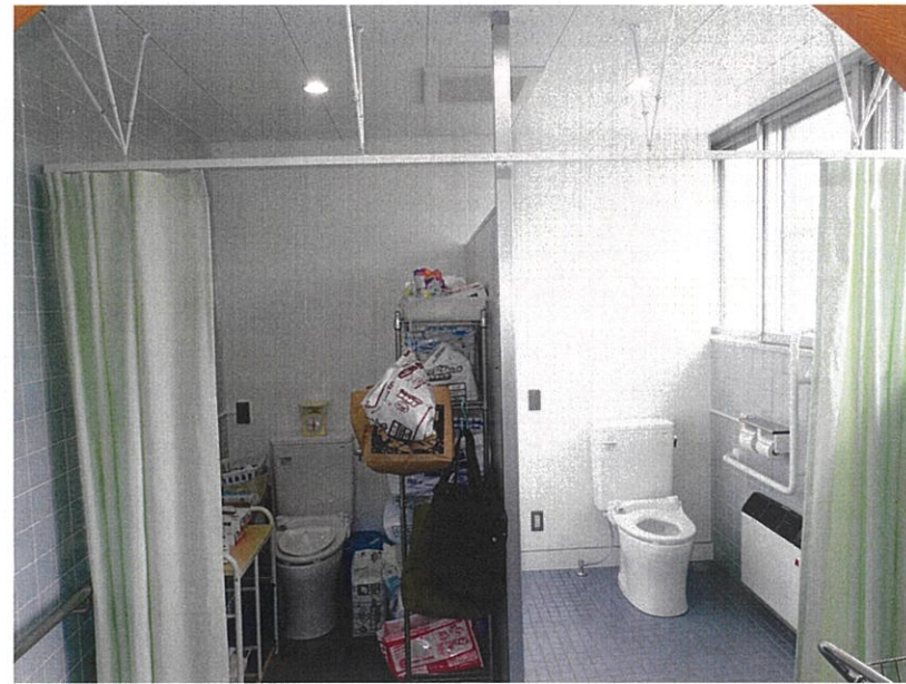
アザレアンさなだ 既存改修工事
