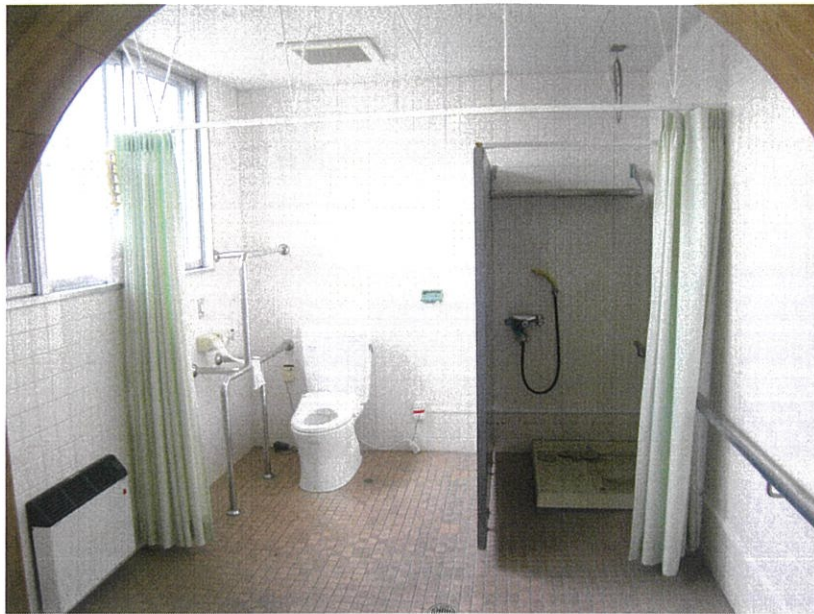
アザレアンさなだ 既存改修工事
