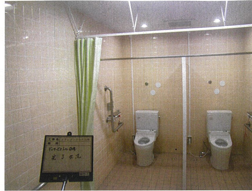
アザレアンさなだ 既存改修工事
