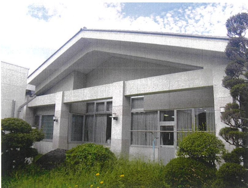
アザレアンさなだ 既存改修工事
