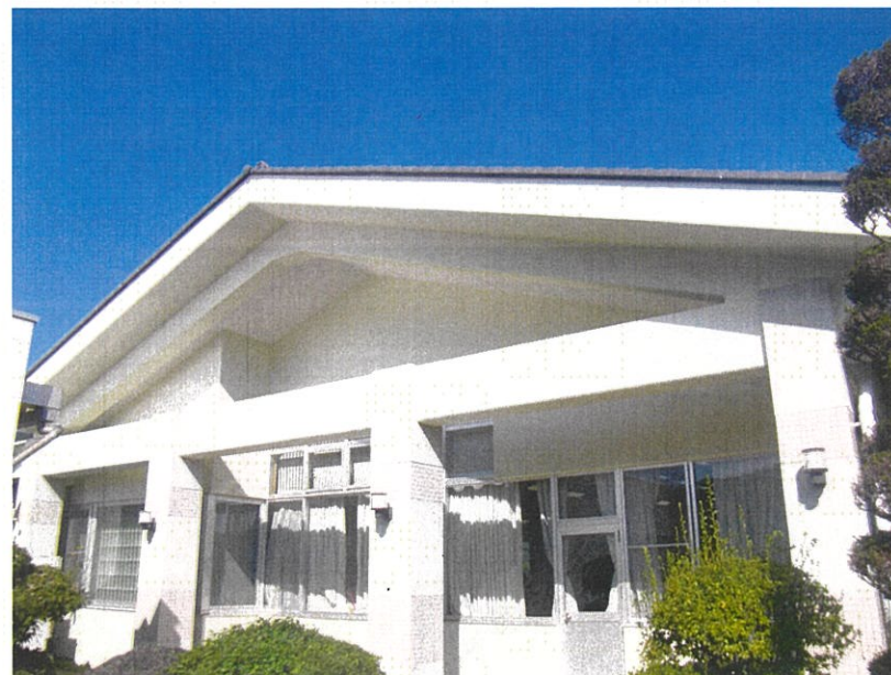
アザレアンさなだ 既存改修工事
