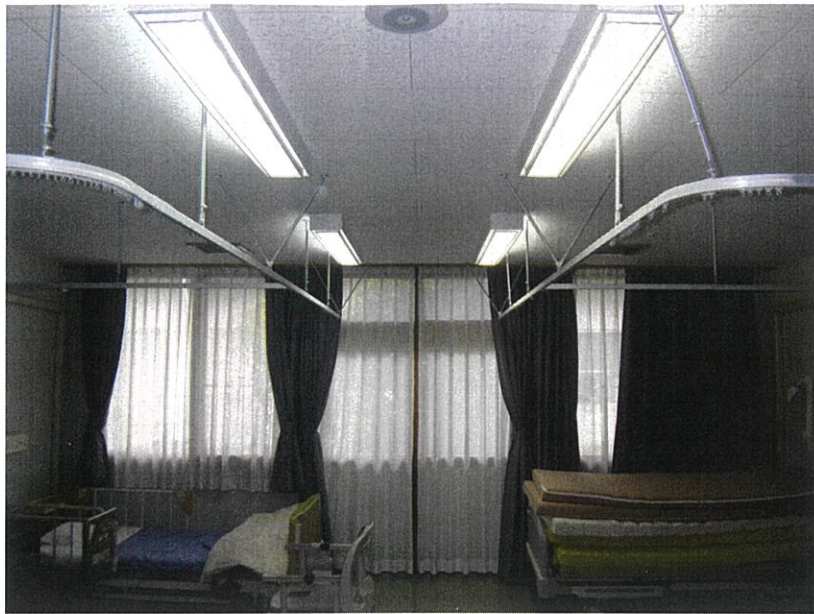
アザレアンさなだ 既存改修工事
