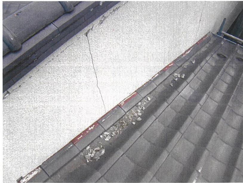
アザレアンさなだ 既存改修工事
