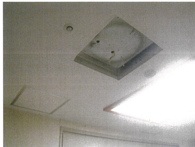
アザレアンさなだ 既存改修工事
