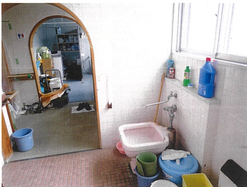
アザレアンさなだ 既存改修工事
