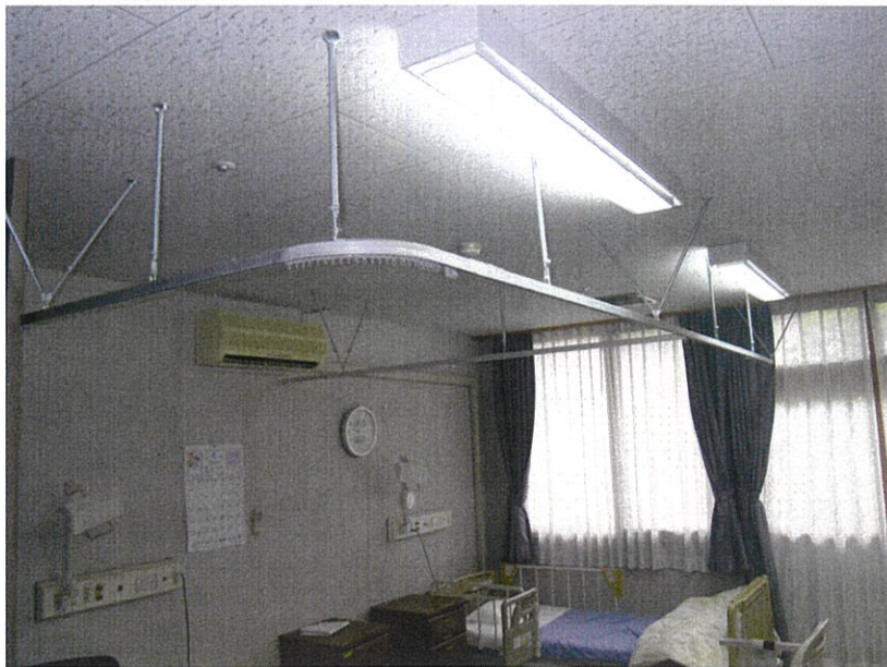
アザレアンさなだ 既存改修工事
