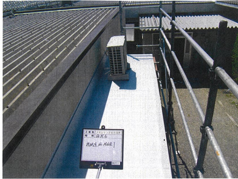
アザレアンさなだ 既存改修工事
