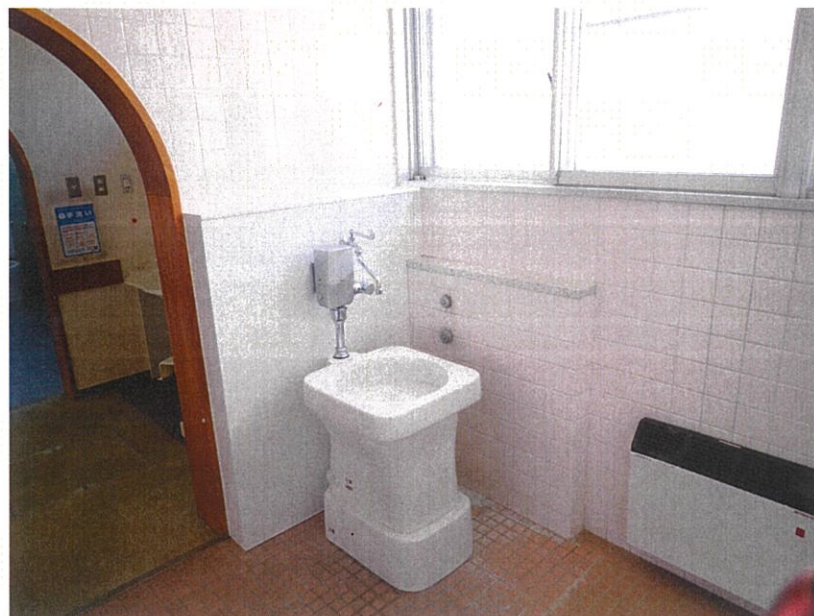
アザレアンさなだ 既存改修工事
