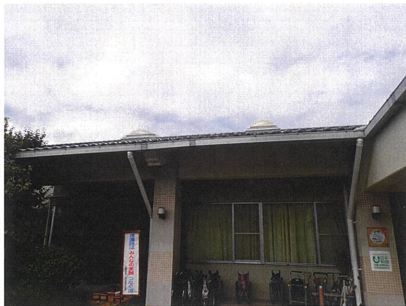
アザレアンさなだ 既存改修工事
