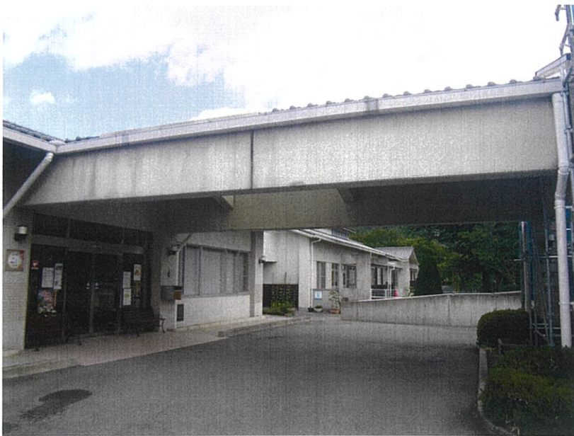
アザレアンさなだ 既存改修工事
