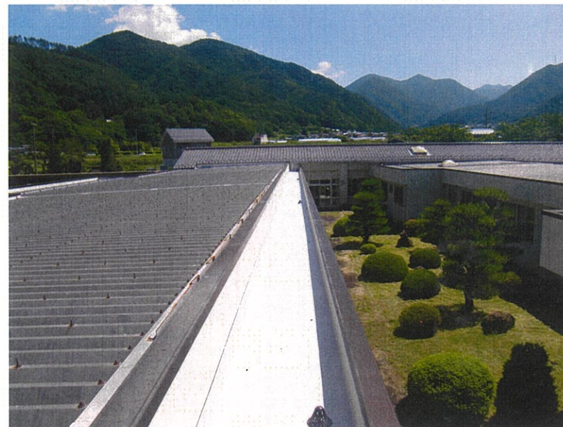
アザレアンさなだ 既存改修工事
