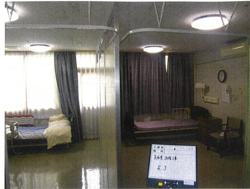
アザレアンさなだ 既存改修工事
