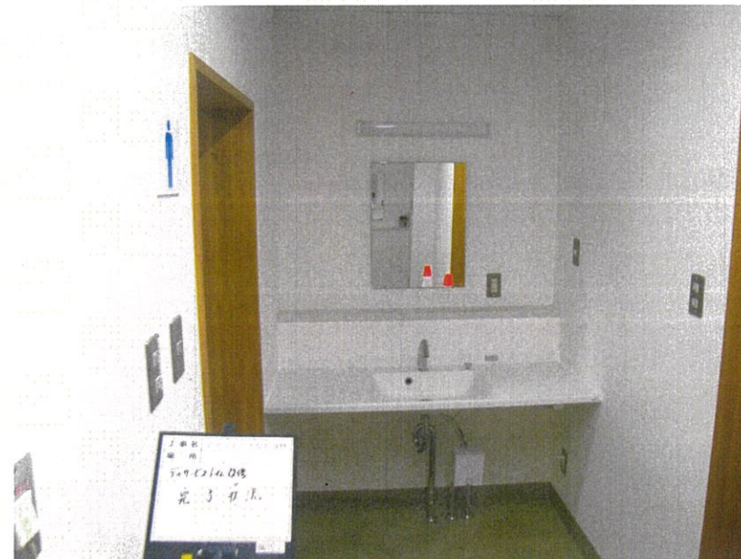
アザレアンさなだ 既存改修工事
