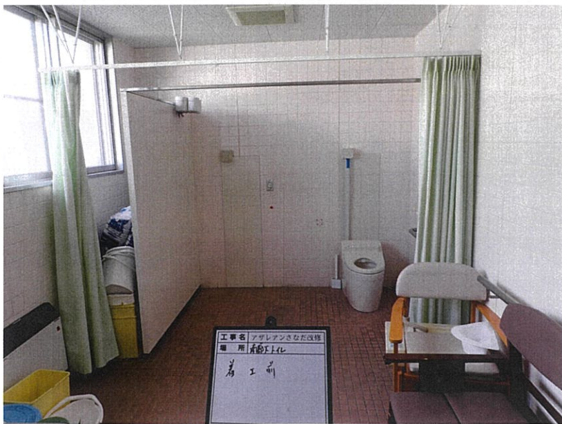
アザレアンさなだ 既存改修工事
