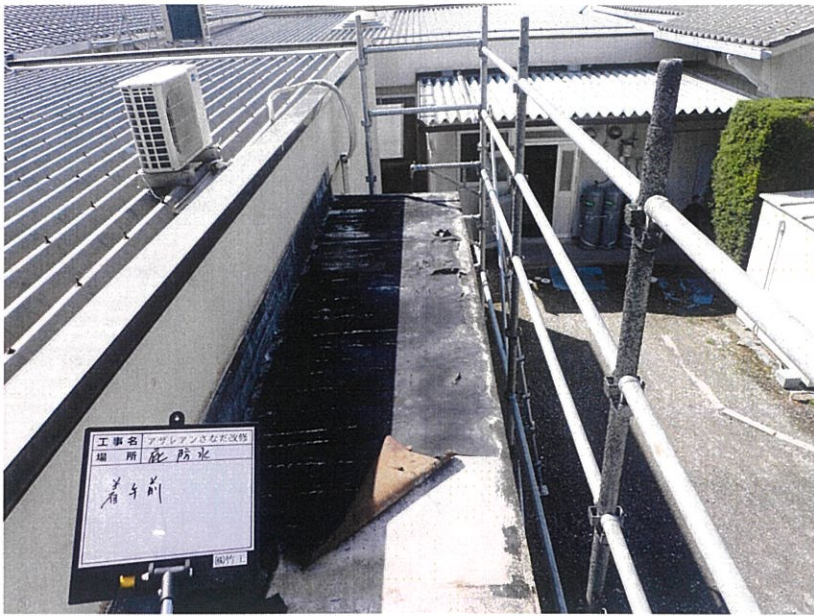
アザレアンさなだ 既存改修工事
