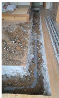
宅内配管の折れが複数あり解体作業
