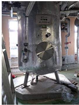
貯湯タンクが傾き お湯が流れ出た
