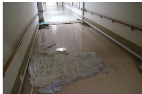
廊下にクラック、隆起した箇所をハンマーで崩し通行可能に その後床の修繕
