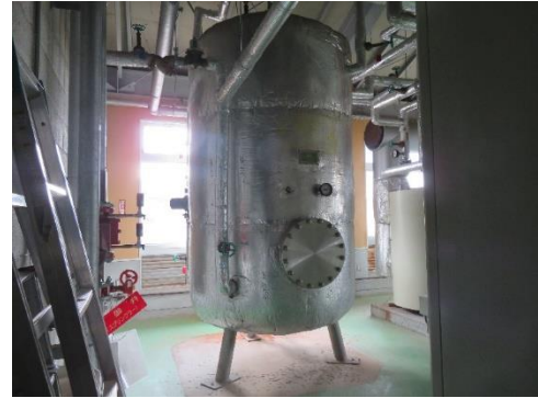
割れた土台撤去、配管修繕し正常に
