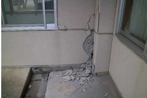
ひび割れしたが壁を取り除き
