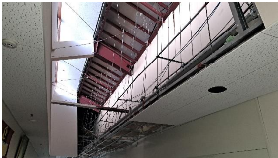
天窓につながる壁面が崩れ落ちる
