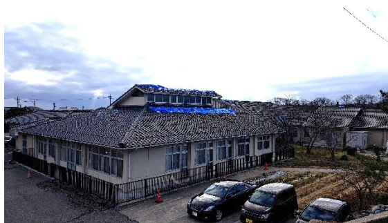
棟瓦が崩れ落ちる 雨漏りが複数箇所発生
