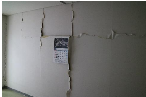
ボードが外れ壁紙を破る
