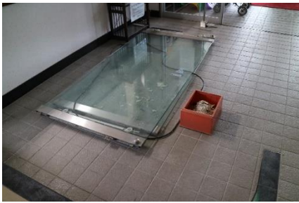
脱落した自動ドアをもとの位置に戻す
