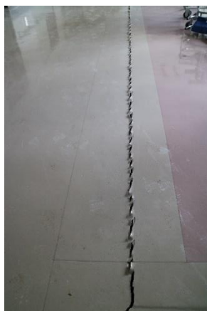
廊下にクラック、隆起した箇所をハンマーで崩し通行可能に その後床の修繕
