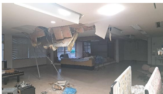
天井から防火壁が崩れ落ち突き破る
