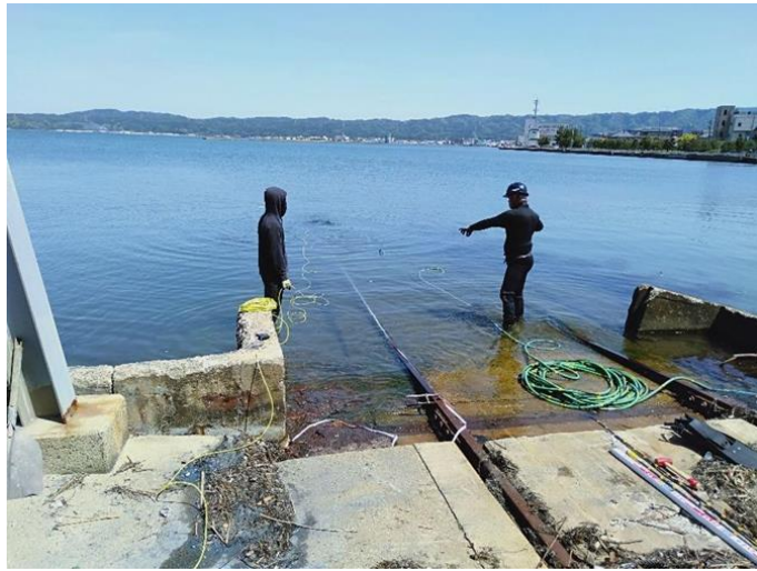
図 4-56 No.4 船台水中部レール測定状況
