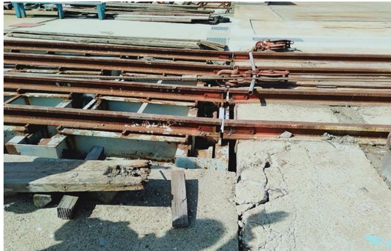
図 4-11 トラバース部損傷
