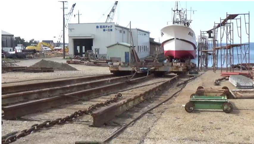
図 4-25 石川ドック 1 号船台（大きな床板被害等なし）
