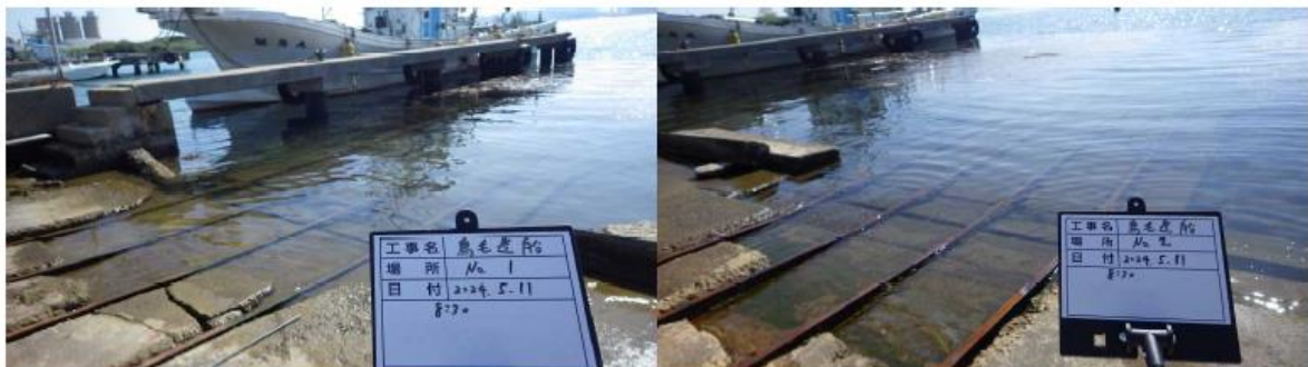
図 4-51 鳥毛 No.4 レール堆積状況 (mm)
