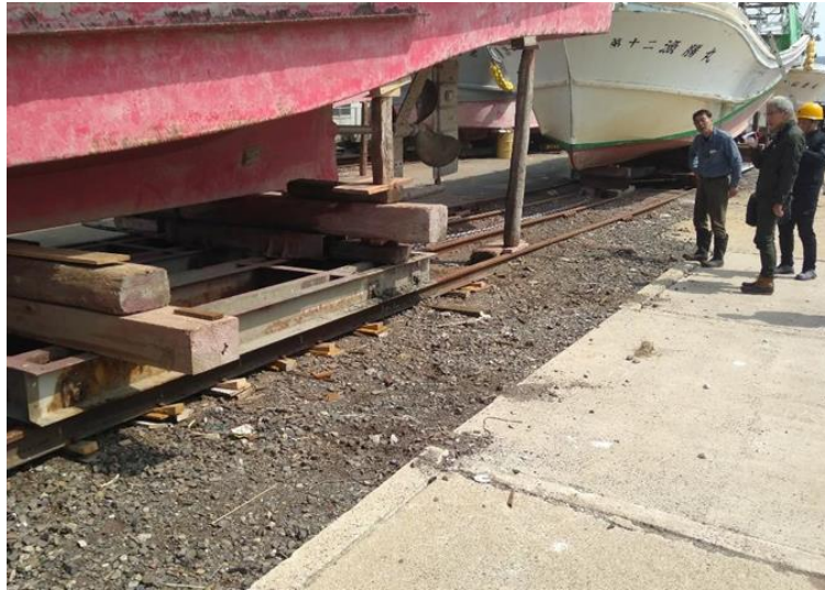
図 4-15 船台レール仮復旧（キャンバー挿入による高さ調整及びレール固定）
