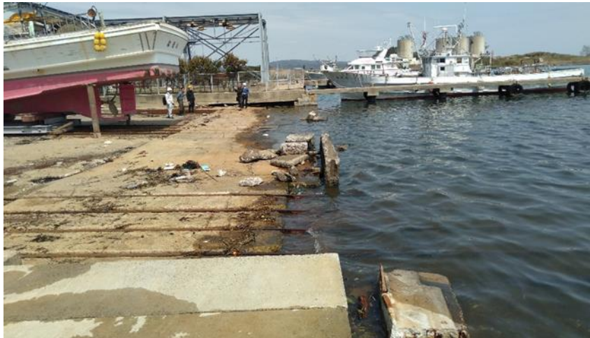
図 5-17 新造工場ヤード側から 2～4 号船台、栈橋
