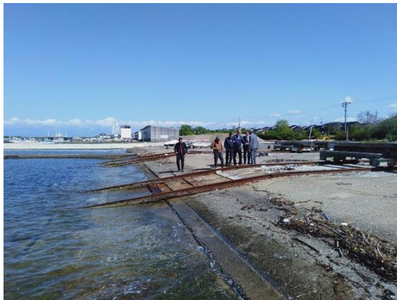
図 4-30 スロープ部（水中部目地開き）
