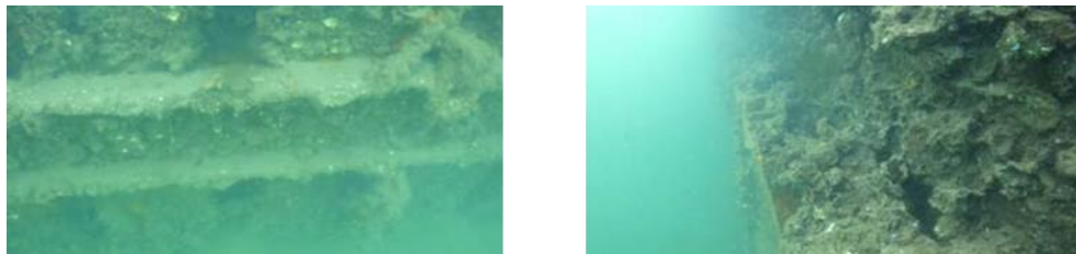
図 4-61 鋼矢板取付鋼材部
