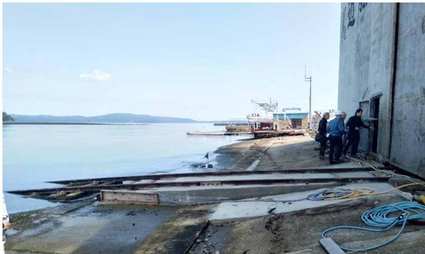
図 5-10 新造工場（御祓川河口傾斜護岸部/上流方から）No.4 船台
