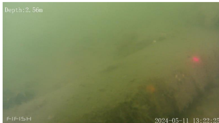
図 4-42 鳥毛造船 No.4 レール水深 2.5m 付近の堆積物
