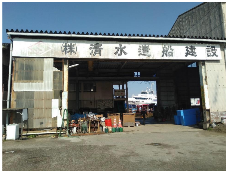
図 4-3 工場建屋外観
