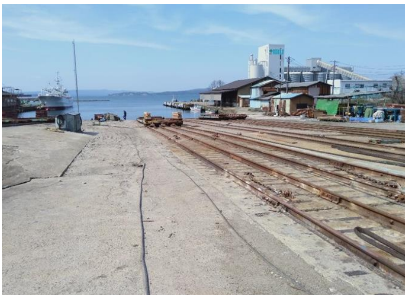
図 4-18 船台ヤード（海側）船台コンクリート床版及びレール
