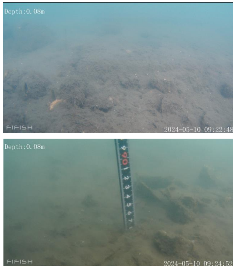
図 4-32 近藤造船 No.1 船台水中部。堆積へドロによりレール、基板は見えない。
