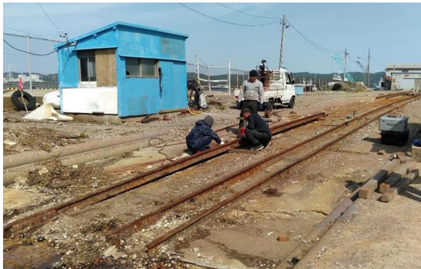
図 4-12 被災レール切断撤去状況（船台 No.1）
