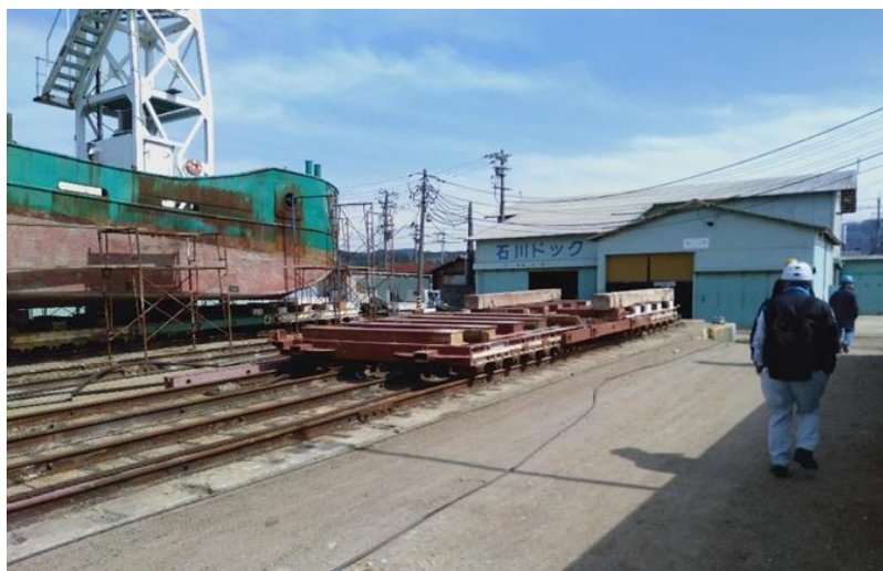
図 4-17 船台ヤード（陸上側）巻き上げ/下げウインチ小屋
