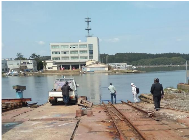
図 4-10 潜水士による土砂撤去状況（エアリフトによる）
