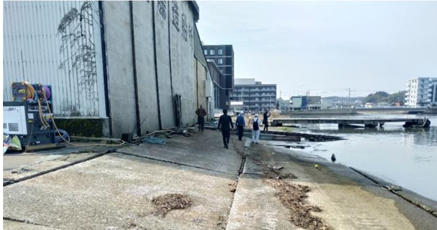
図 5-9 新造工場船台（御祓川河口傾斜護岸部/下流方から）
