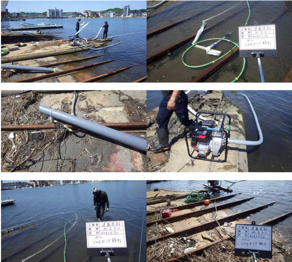
図 4-37 近藤造船 エゼクターによる浚渫（土砂除去）作業
