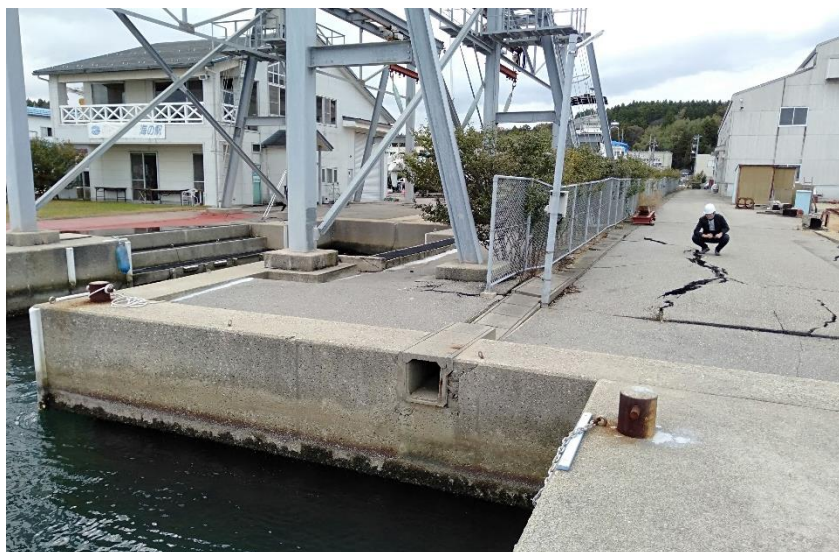
七尾ベイマリン境界部（排水側溝）
