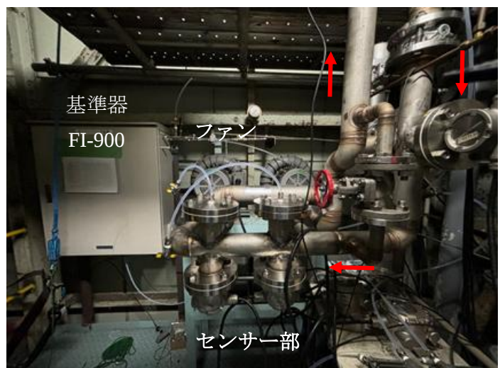
図 51-3. 現場での設置状況
