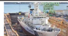
巡視船の修繕の様子 出典:佐世保重工業
