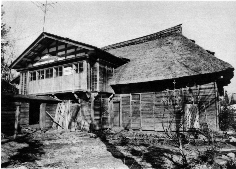
佐藤家住宅 修理前 背面外観 修理工事報告書より
