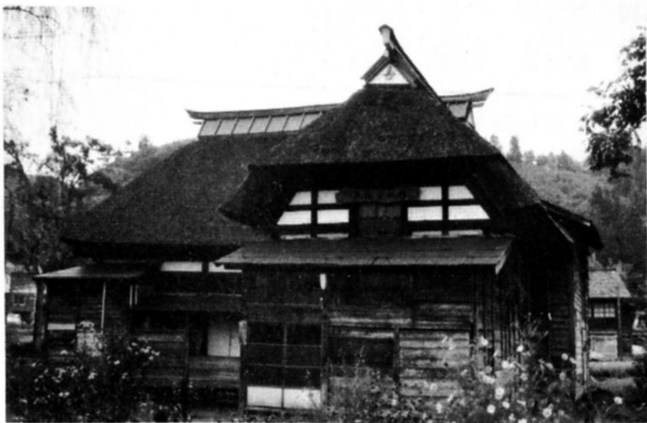
① 入広瀬村立民俗資料館(北魚・入広瀬村大字大栃山) (旧浅井秋雄家 同所)
