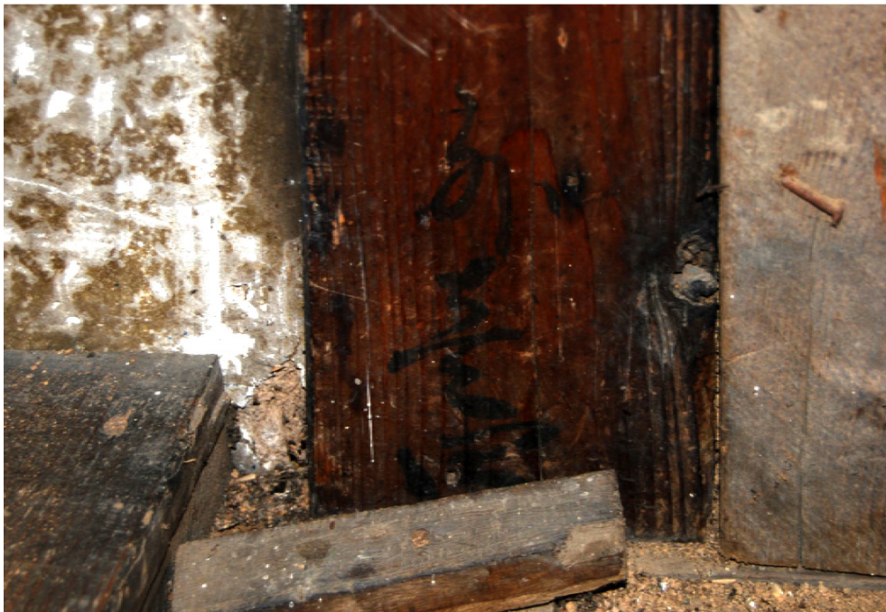
主屋 座敷床の間背面柱 北東より 「外巻 四」と読むことができる。当初床、棚部分は当初と見ることができる。
