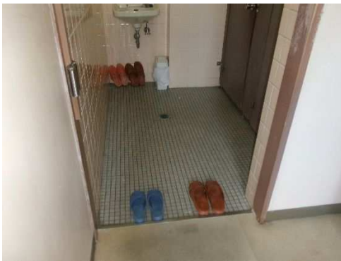
(3階女子便所) 床段差解消、内部改装
