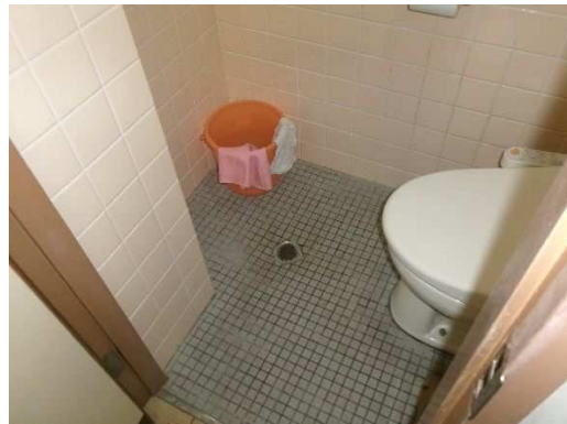
(1階静養室内便所) 床段差解消、床仕上げ変更
