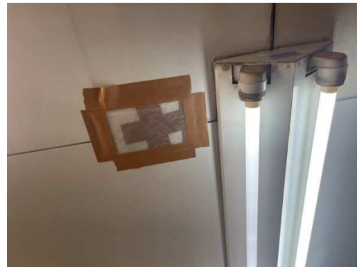
(1階厨房) 天井雨漏り補修
