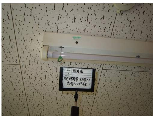
(3 階廊下) 非常用照明取り替え 3 階→10 箇所
