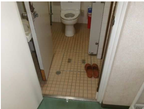
(1階洗面便所) 床段差解消、内部改装
