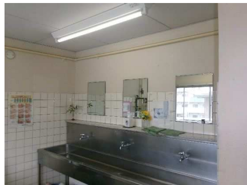
(2階洗面) ステンレス洗面台取替 (既製品洗面化粧台に変更)
