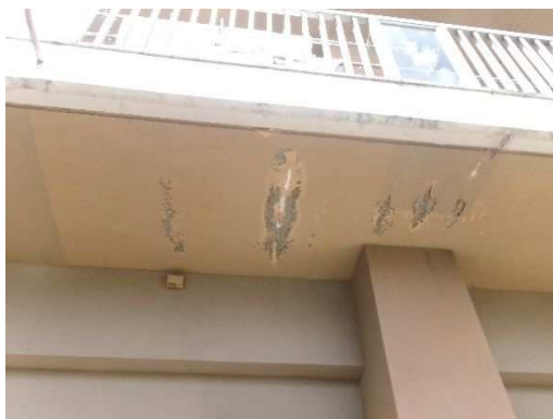
外観（南側） 外壁補修、塗装塗替え
