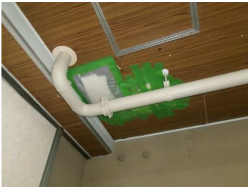
(1階食堂) 天井雨漏り補修
