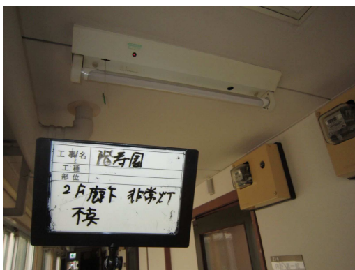
(2 階廊下) 非常用照明取り替え 2 階→13 箇所
