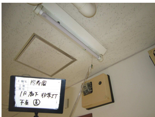
(1 階廊下) 非常用照明取り替え 1 階→6 箇所
