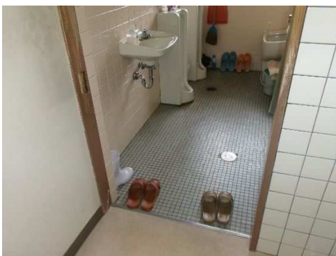
(2階男女便所) 床段差解消、内部改装
