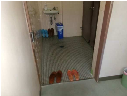
(2階女子便所) 床段差解消、内部改装
