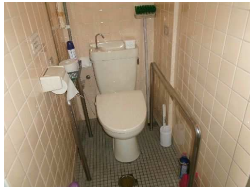
(1階男子脱衣室内便所) 床段差解消、内部改装
