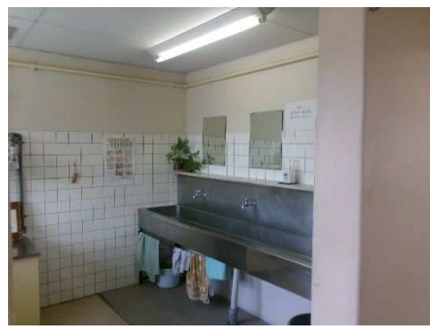
(3階洗面) ステンレス洗面台取替 (既製品洗面化粧台に変更)
