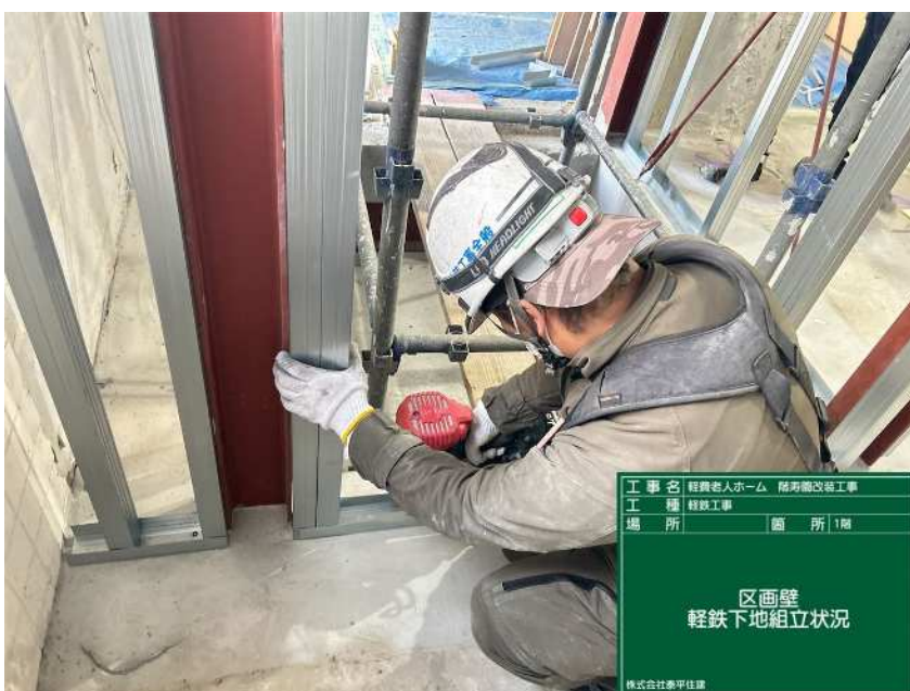
工事名 経典老人ホーム 随所箇改修工事 工種 軽鉄工事 場所 箇所 2階 区画壁 Uタイト打ち完了 株式会社泰平住建
