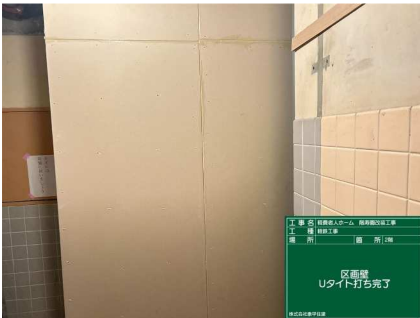
工事名 経典老人ホーム 随所箇改修工事 工種 軽鉄工事 場所 箇所 2階 区画壁 Uタイト打ち状況 株式会社泰平住建
