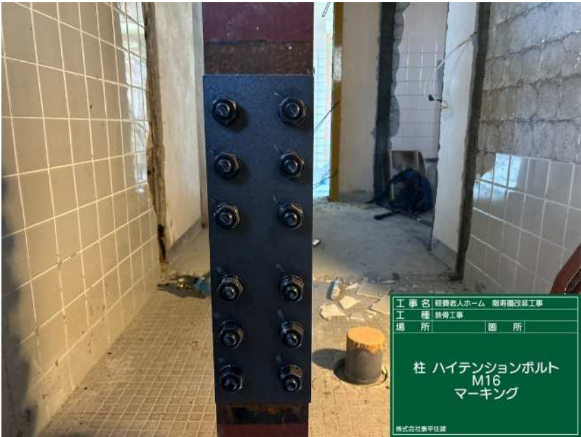
工事名 経典老人ホーム 船寿庵改装工事 工種 鉄骨工事 場所 箇所 柱 ハイテンションボルト M16 一次締め 株式会社泰平住建
