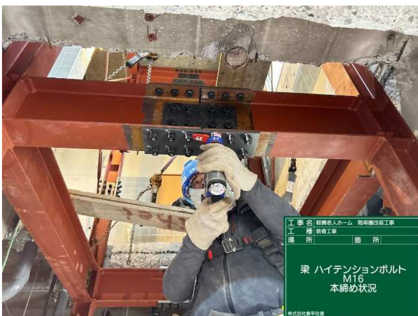
工事名 経典老人ホーム 船海蔵改装工事 工種 鉄骨工事 場所 箇所 梁 ハイテンションボルト M16 マーキング 株式会社豊平住建
