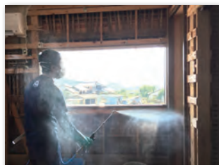
高圧洗浄機で泥を洗い流す
