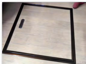
写真④ このような点検口から床下を確認できる
