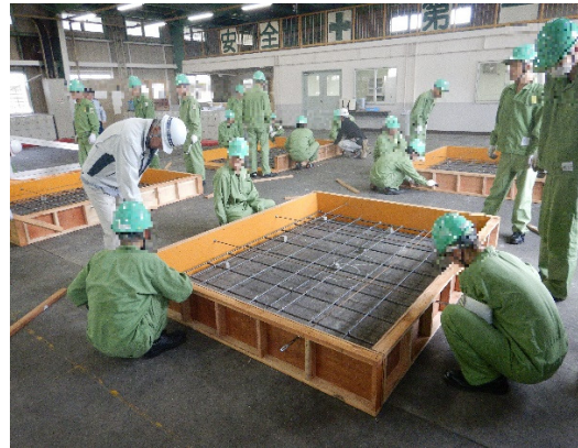
鉄筋型枠工事実習
