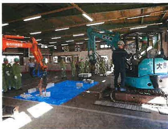
解体工事実習
