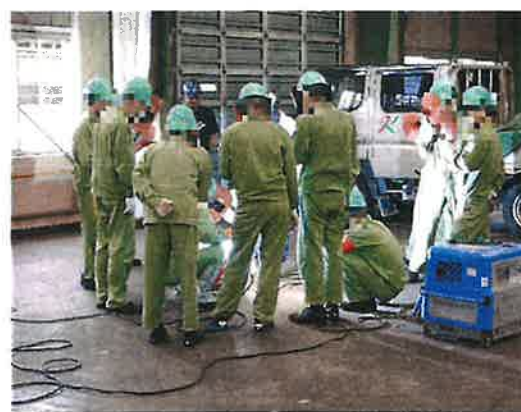
溶接工事実習
