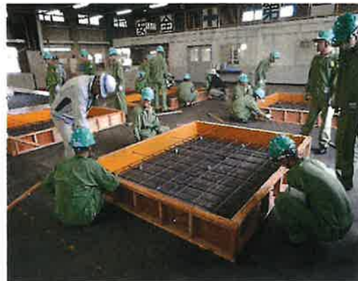
鉄筋型枠工事実習
