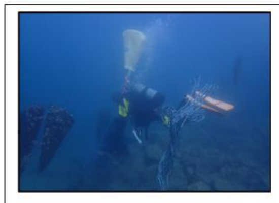
リフトバッグを使って ロープ固定用の土俵を運ぶ
