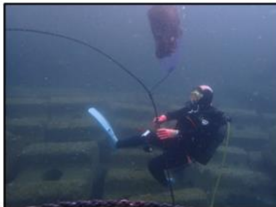
コンブロープ設置
