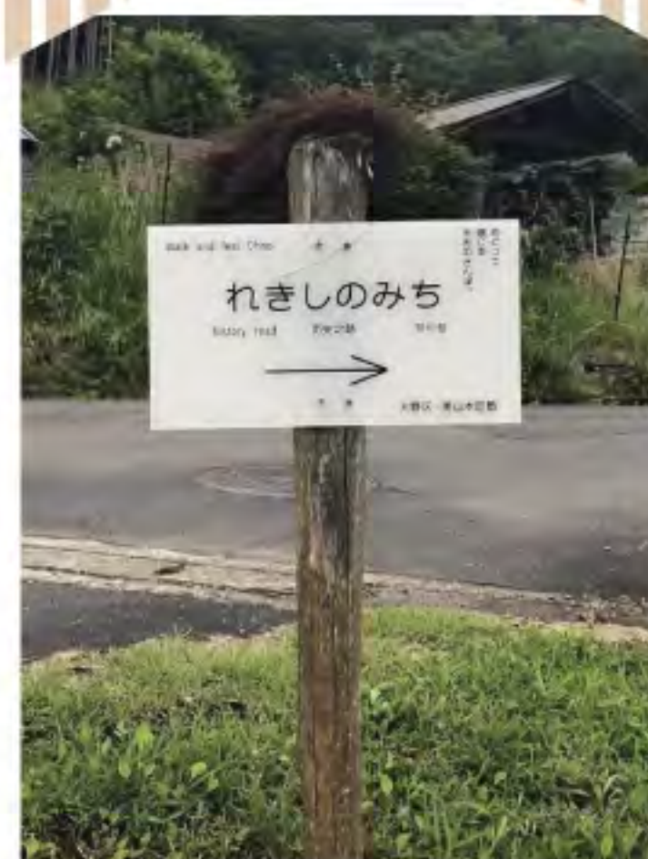
↓ひび割れた看板
