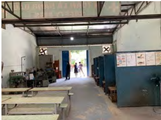
溶接ワークショップ内全景
