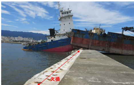
乗揚状況及び防波堤の損傷状況
