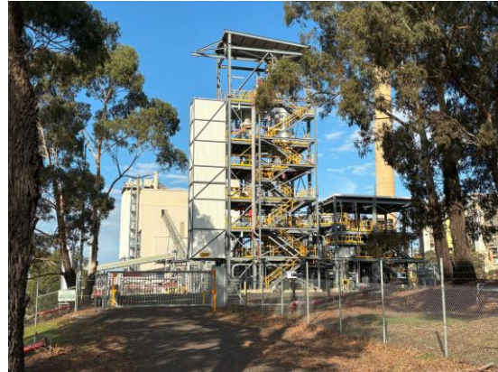
石炭ガス化施設(左)と水素生成施設(右)
