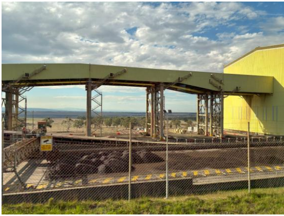
(褐炭輸送用ベルトコンベアー①)
