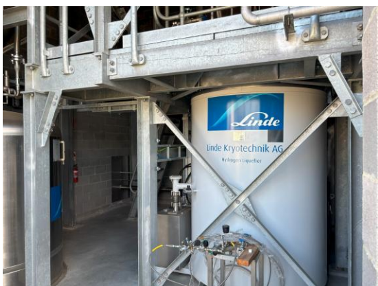
(Linde 製液化装置)
