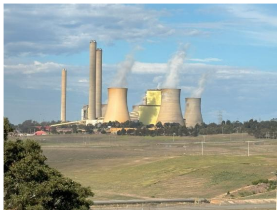
(採掘場傍の火力発電所)
