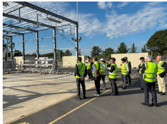
(液化水素貯蔵スペース)
