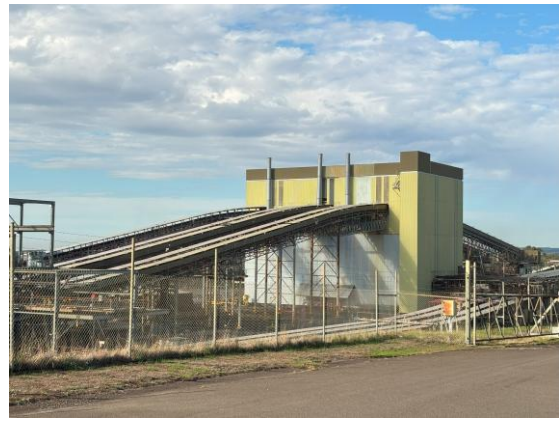
(褐炭輸送用ベルトコンベアー②)
