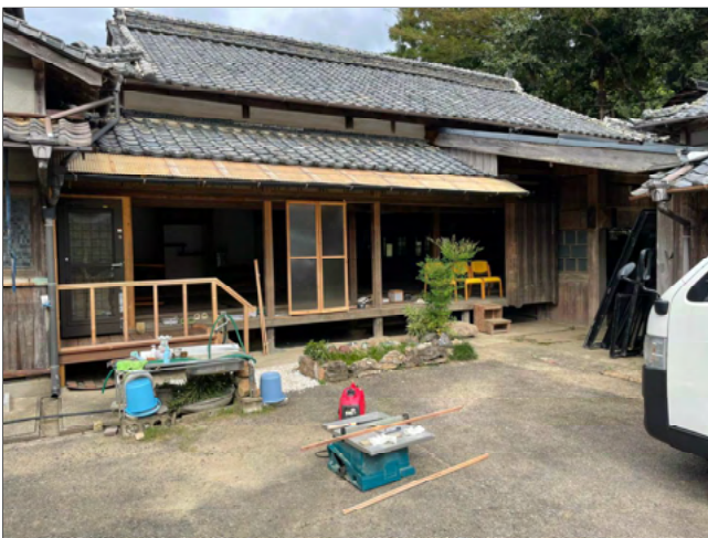
fig5. 仮設置現場調整
