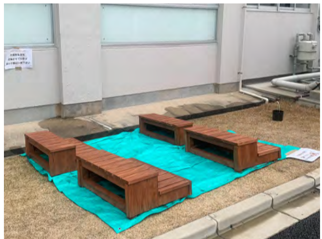
fig6.防腐剤塗布後の踏み台の様子
