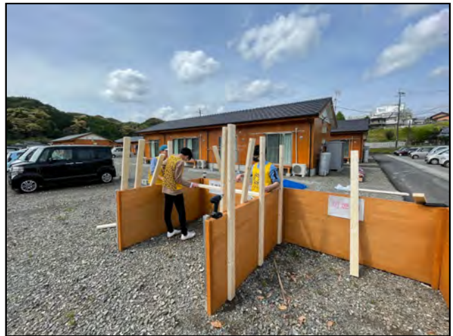
fig2. 柱の施工の様子
