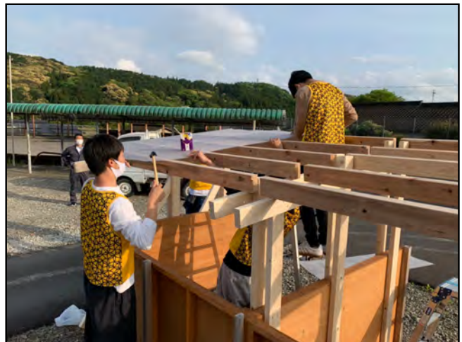
fig4. 屋根の施工の様子
