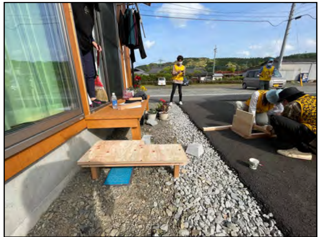
fig8. 踏み台の施工の様子1
