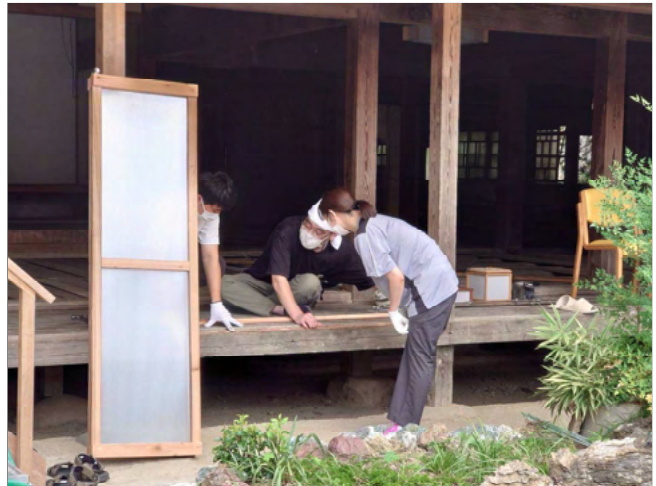
fig4. 仮設置現場調整
