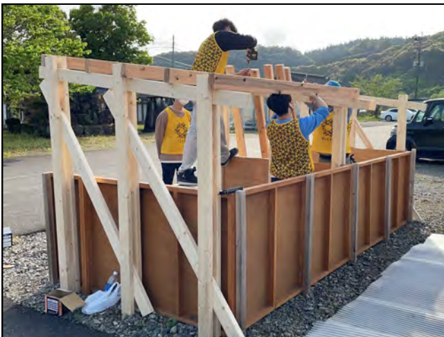
fig3. 梁の施工の様子
