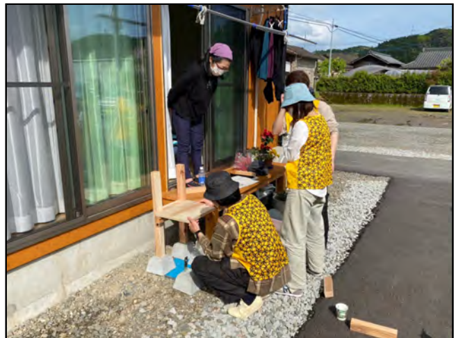
fig10. 踏み台の施工の様子3
