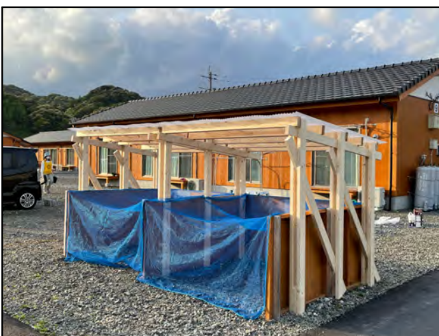
fig5. ゴミ置き場屋根完成写真
