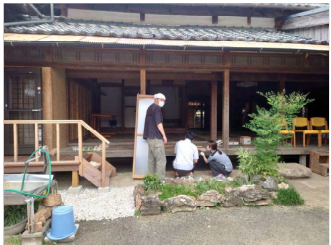
fig6. 仮設置現場調整
