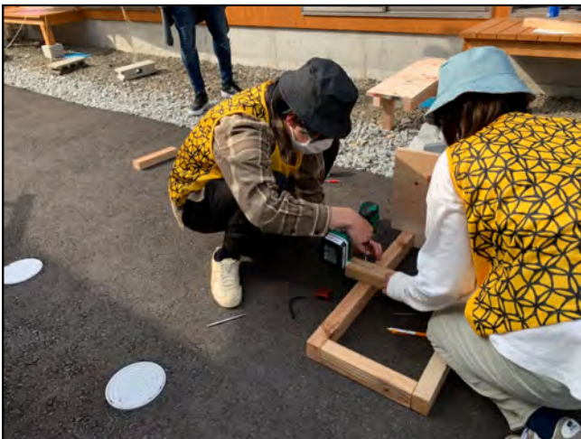
fig9. 踏み台の施工の様子2
