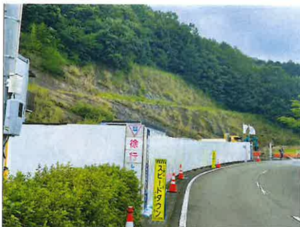
fig1.球磨村災害公営住宅の建設視察 1
