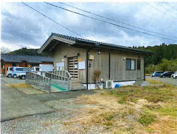
fig5.人吉市石野公園仮設団地のみんなの家
