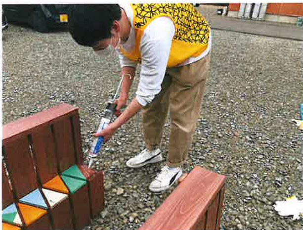
fig3.パッチワークの取り付け作業風景
