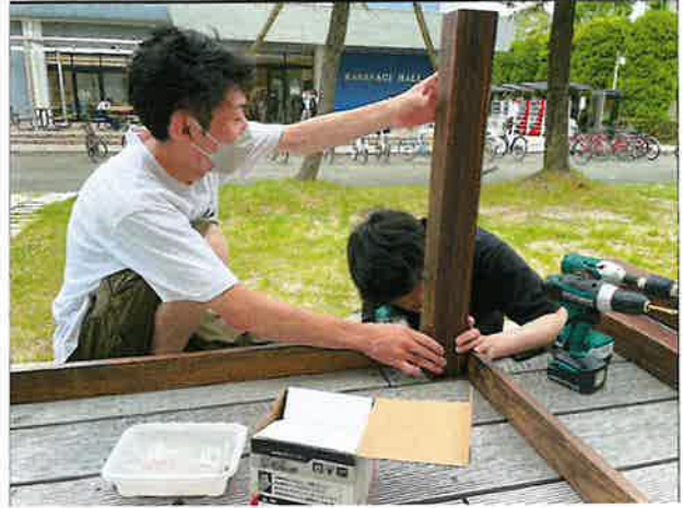
天板を支える部材と脚を固定
