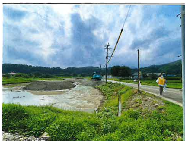
fig4.山江村災害公営住宅の建設視察
