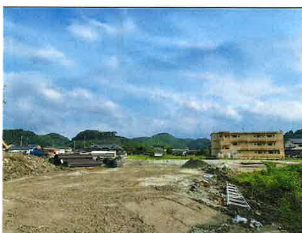
fig6.人吉市災害公営住宅の建設視察
