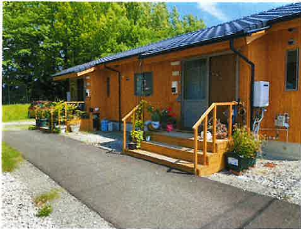
Fig1仮設団地内の視察を行った
