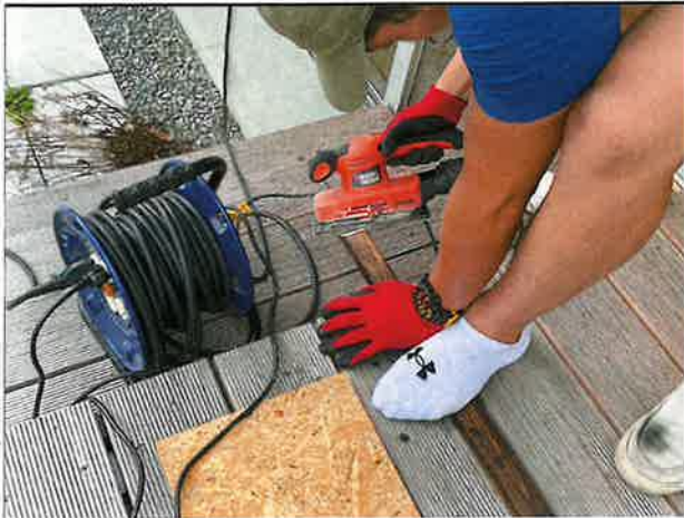
部材切り出し後、切断面＝接着面を研磨
