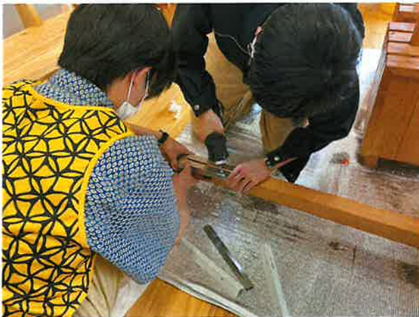
fig3.ステンレス継ぎ手の取付する様子
