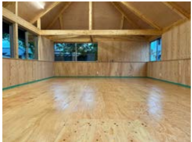
fig4. 床塗り後の様子
