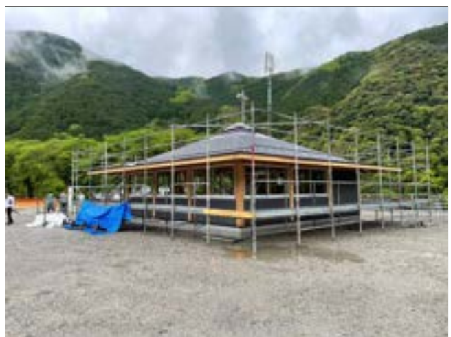
fig6. 中津道みんなの家の施工中の外観
