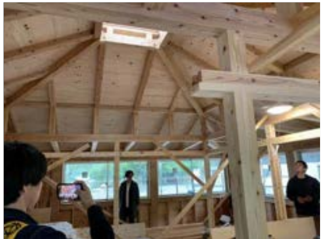
fig4. 中津道みんなの家の施工中の内観
