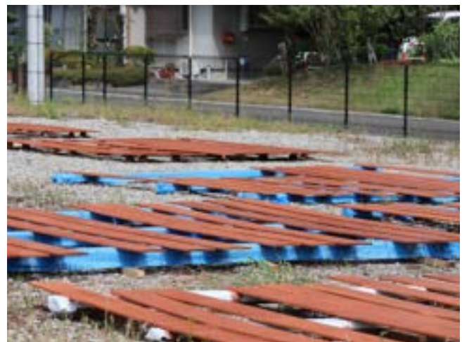
fig6. 壁材塗り後の様子
