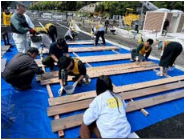
fig1. 塗装作業の様子
