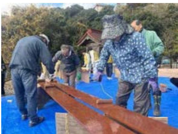
fig5.外壁塗装の様子
