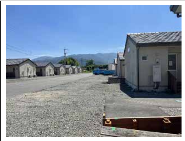
fig1. 大王原仮設団地
