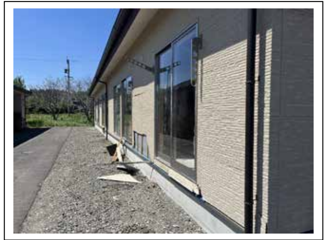
fig2. 大王原仮設団地
