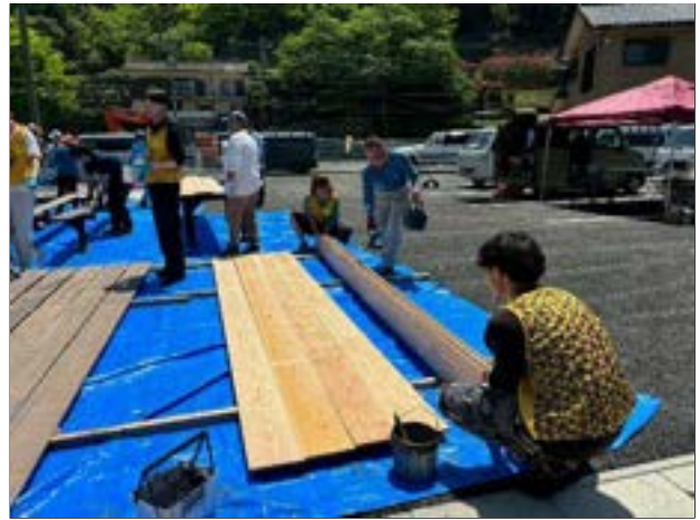
fig2. 塗装作業の様子
