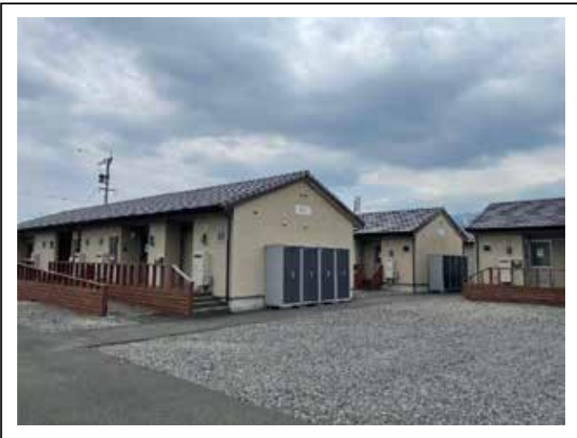
fig3. 大王原仮設団地
