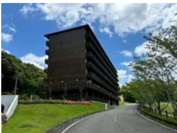
fig5.仮設住宅付近に竣工した住宅
