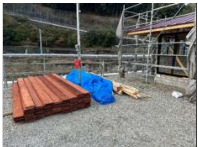
fig6. 塗り終わった板の保管の様子
