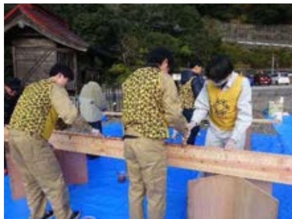
fig4.外壁塗装の様子
