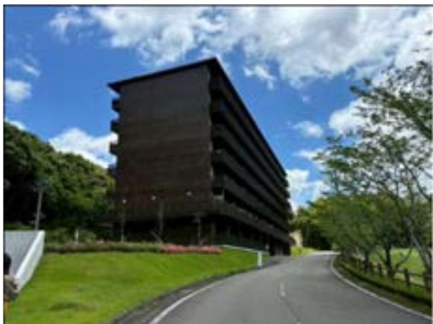
fig3.仮設住宅付近に竣工した住宅
