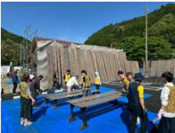
fig3. 塗装作業の様子
