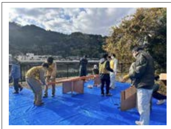
fig2. 塗装作業の様子
