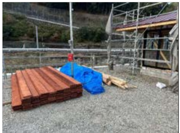
fig6. 塗り終わった板の保管の様子
