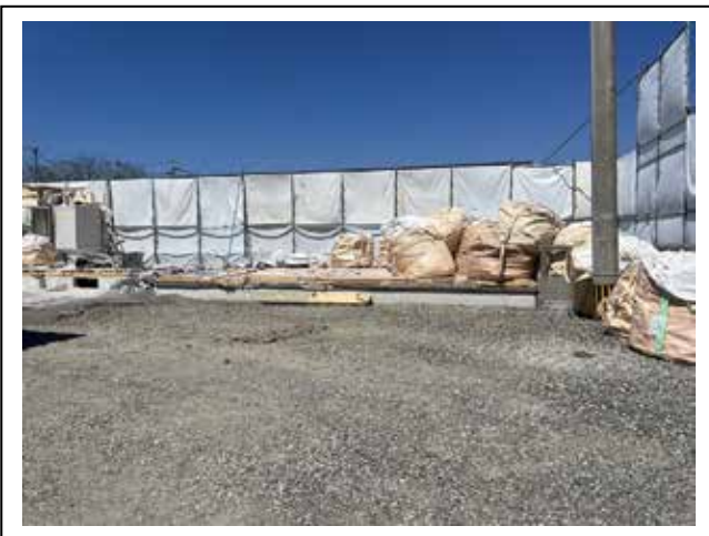
fig3. 大王原仮設団地
