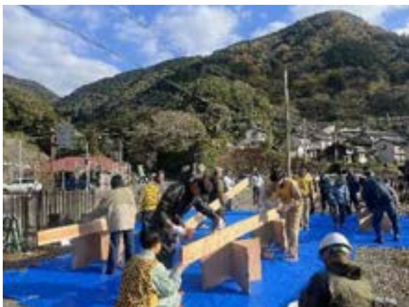
fig3.外壁塗装の様子
