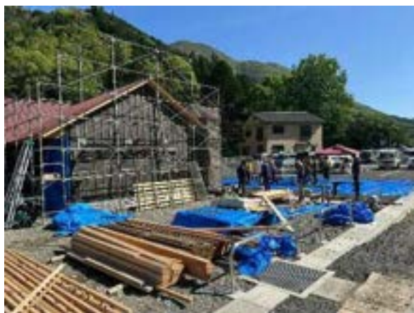
fig2.外壁塗装の様子
