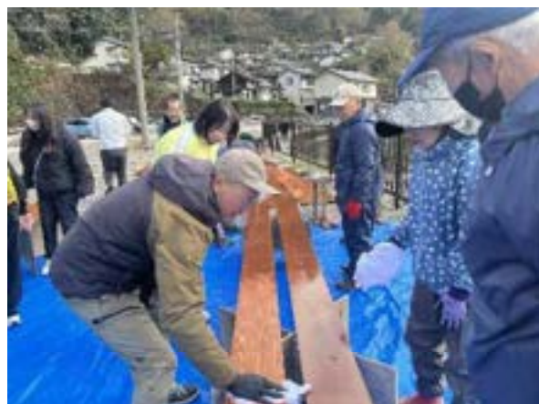
fig2.外壁塗装の様子
