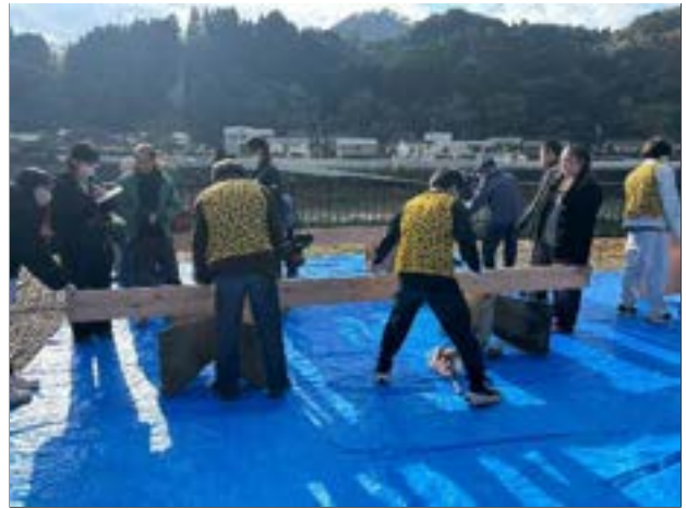
fig2. 外壁塗装の様子
