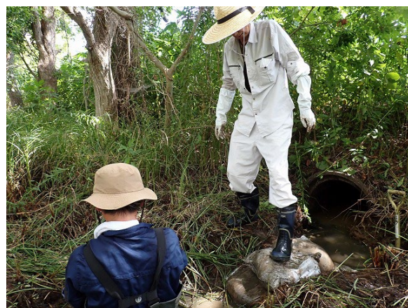
水路に土嚢袋を設置
