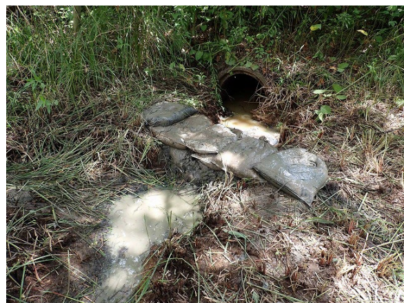
土嚢袋の設置状況
