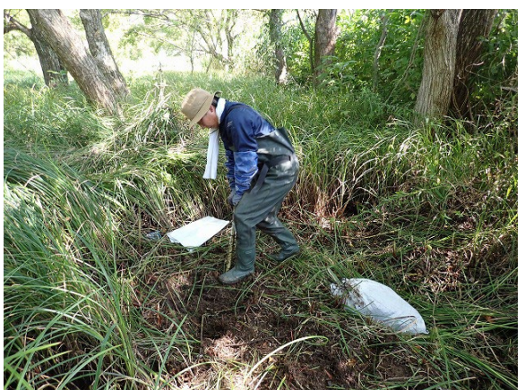
土嚢袋に土入れ作業
