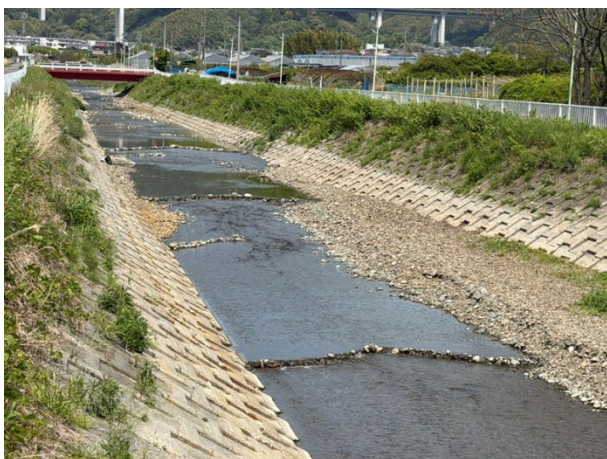
バープ工 20 基が完成
