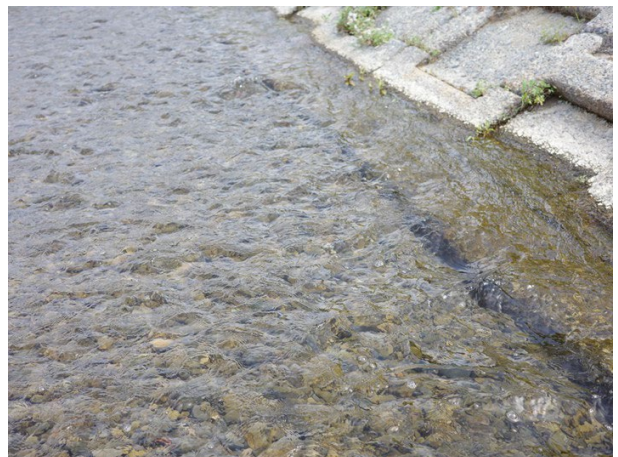
露出した護岸基礎
