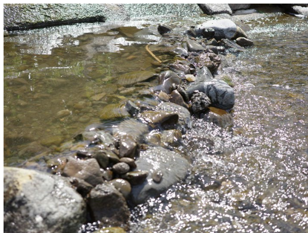
バープ工によりせりあがった水
