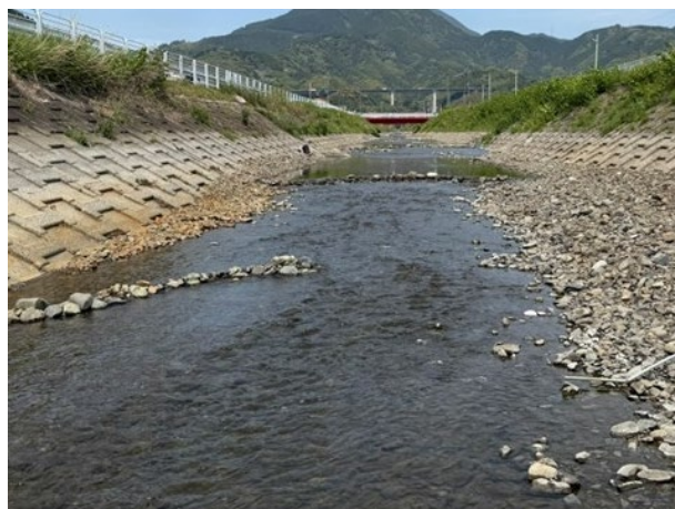
バープ工を回り込んで波打つ水流
