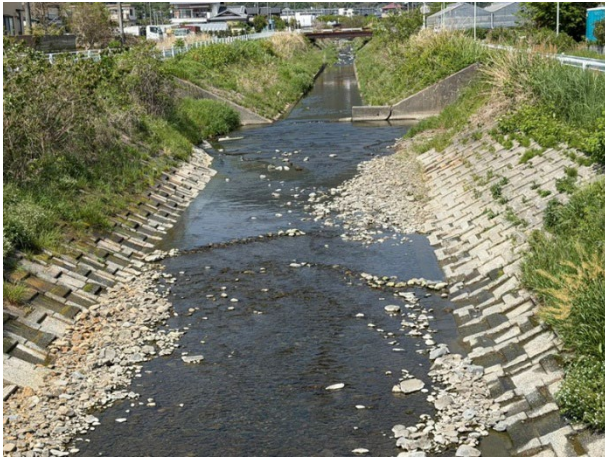
川の粒径と勾配（落差工付近：礫区間）
