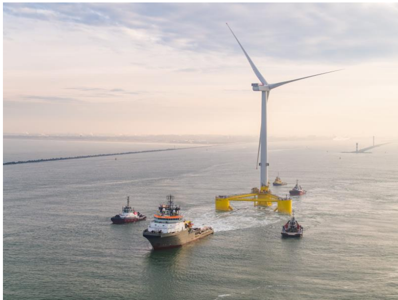
図 16 曳航の様子（先頭がアンカーハンドリングタグ船）
