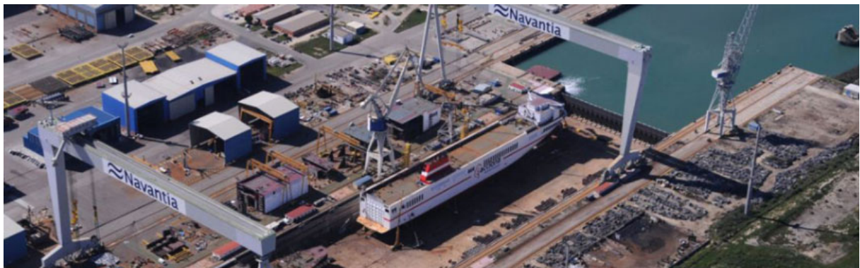
プエルトレアル造船所の乾ドック
