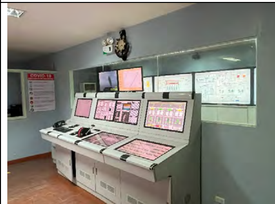
機関シミュレーター① (機関室環境再現型)
