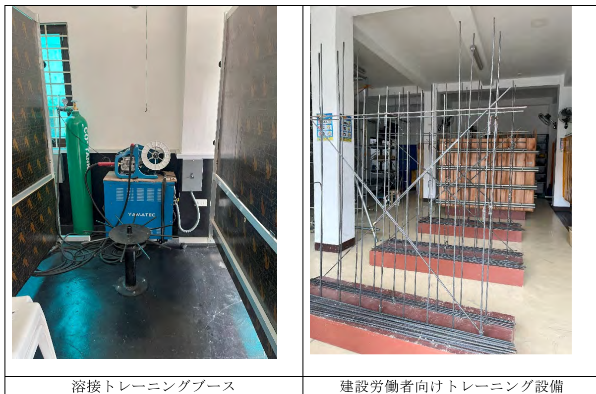
図 26 送出機関の溶接トレーニング設備
