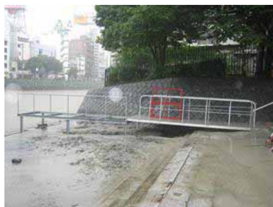
図 4-1-2 仮設棧橋設置工事 (福博であい橋)
