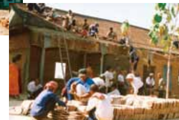
▲古い校舎を解体する作業を手伝う村人たち
