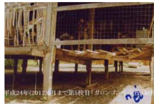
▲ガロンゴン小学校旧校舎
