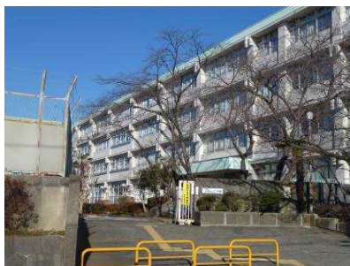
4 階建てと増築棟 2 階建てがあり非常に大きな施設である。利用者は地域住民が中心であり、徒歩、自転車、自家用車で来所する。
