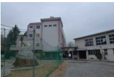
都営三田線西巣鴨駅から徒歩、国道に面して立地するにしすがも創造舎。地下 1 階、地上 4 階建ての RC 造の校舎と演劇の会場としても利用できる体育館がある。
