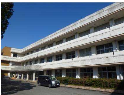
民間企業に1階部分を貸している。竹の加工や食品加工を行っている。小高い山の上にあるため、周辺からの苦情等はない。
