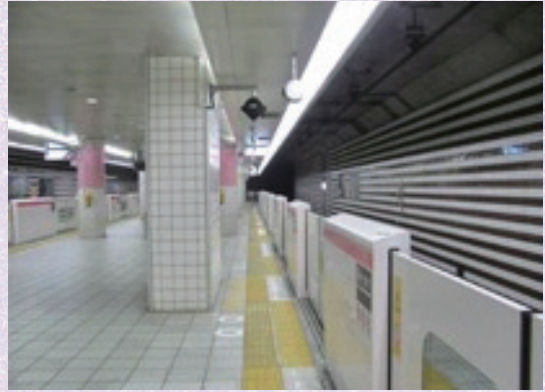
可動式ホーム柵の設置
