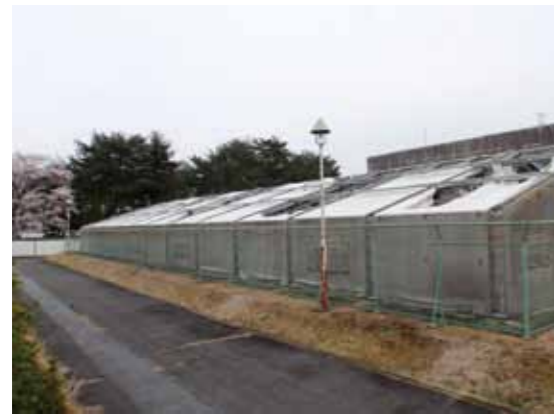
上屋シート (改修前)
