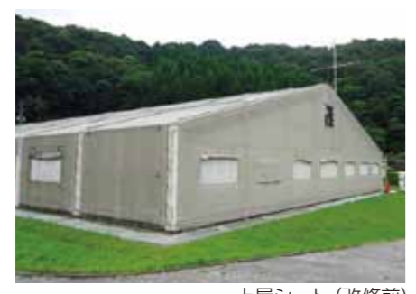
上屋シート (改修前)
