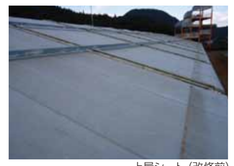
上屋シート (改修前)
