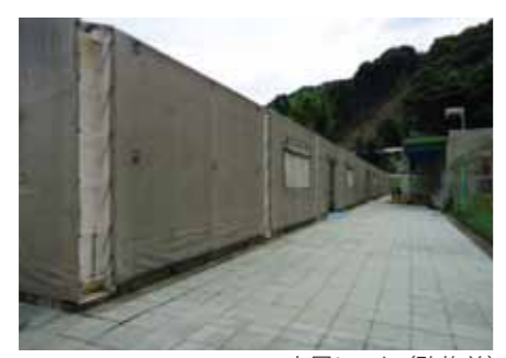
上屋シート (改修前)
