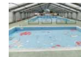
プール (改修前)
