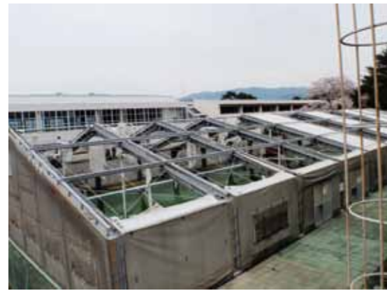
上屋シート (改修前)
