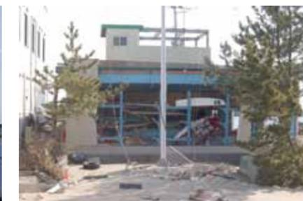
津波により側壁が崩壊、甚大な被害を受け、艇庫は危険建物と診断。現在は撤去され更地となっている。
