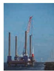
モノパイル打設 (500トンマーで打設)
