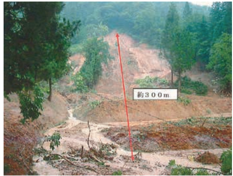
▲①土砂崩れを起こした部分の状況
