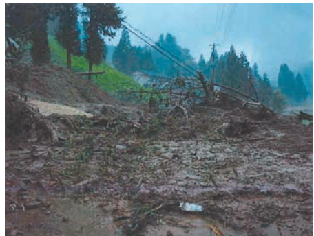
▲③主要地方道栃尾山古志線が、土砂に埋もれ遮断された状況（南方方向より撮影）
