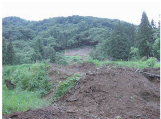
▲土砂が崩れた様子
