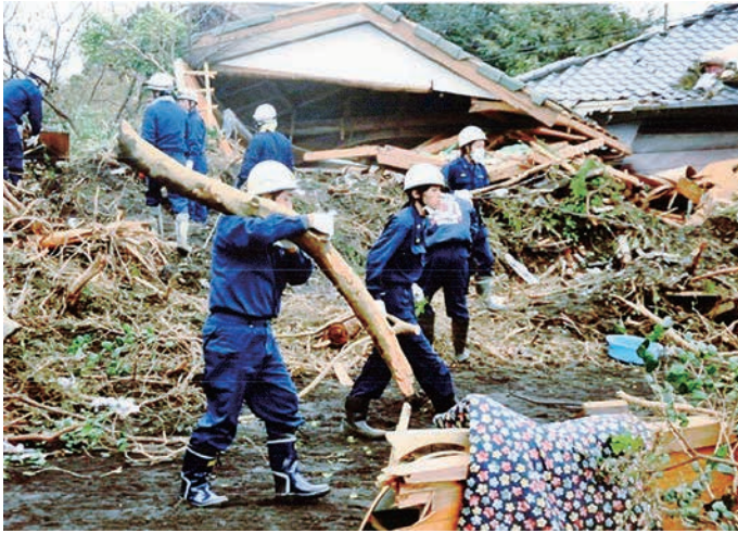
▲泥流で樹木が住宅地へ 片づける消防団員
