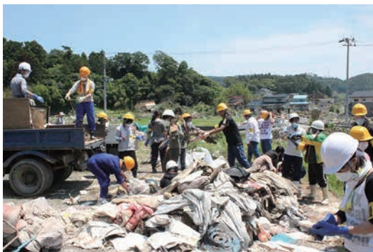
▲石巻がれき撤去の様子
