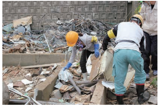
▲気仙沼がれき撤去の様子
