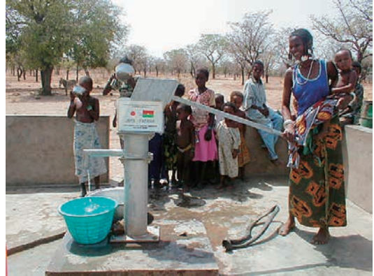
▲ポンプ式深井戸の設置（33基を設置）
