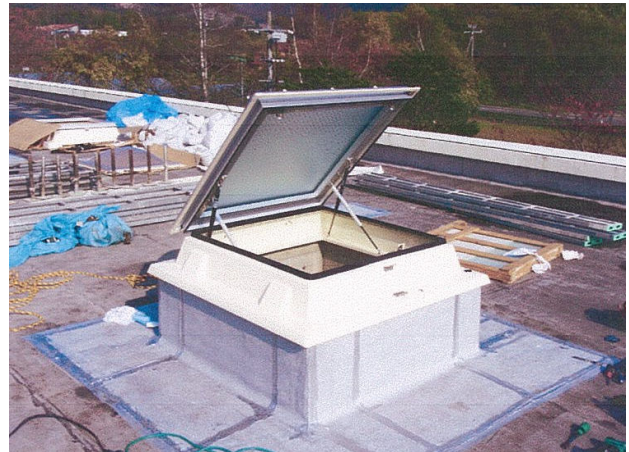
工事後の「屋上トップライト」
