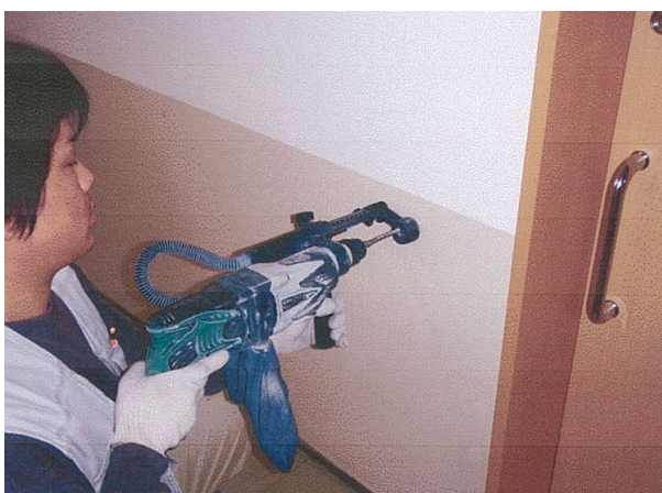
設置中の「共用廊下手摺」
