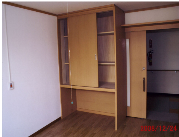
工事後の「建具」
