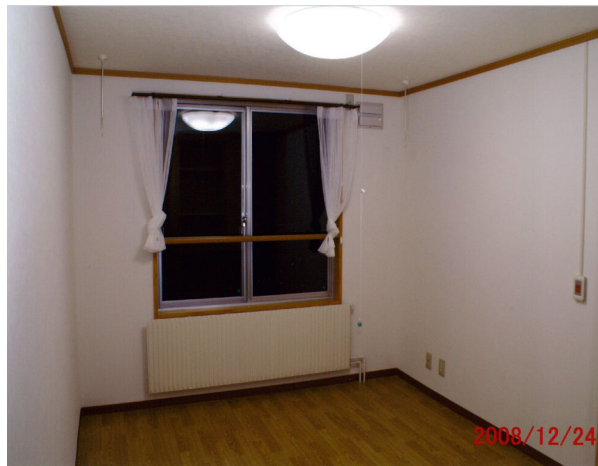
工事後の「居室」
