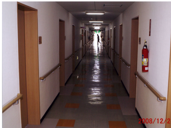
設置後の「共用廊下手摺」
