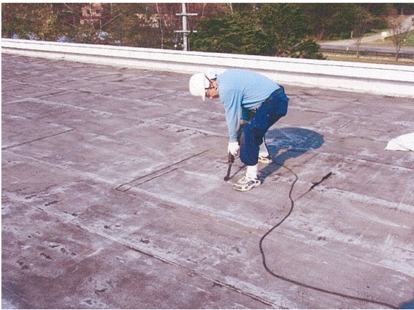
工事中の「屋上トップライト」
