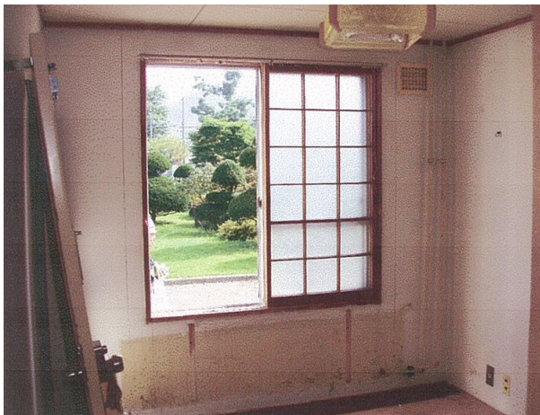
工事前の「居室」
