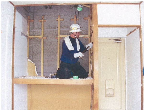
工事中の「建具」
