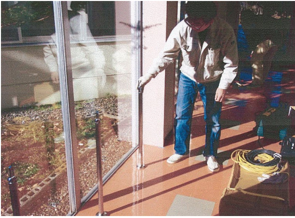
設置中の「共用廊下手摺」
