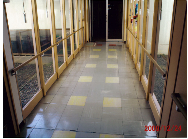
設置後の「共用廊下手摺」
