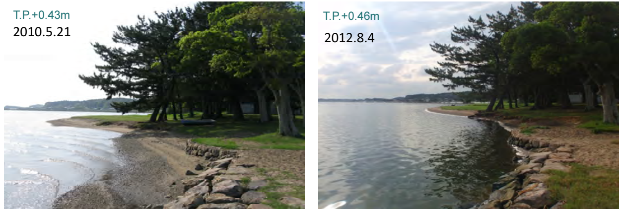
写真 2-7 茨城県涸沼の地盤沈下による変状
