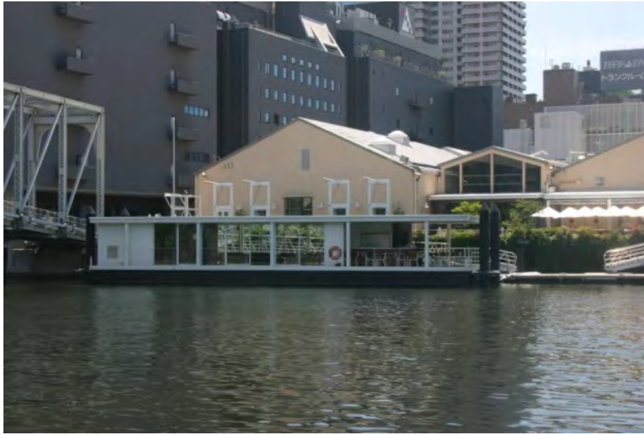
写真 2-11 浮体式海上レストランであるウォーターライン（東京品川天王洲）手前の白い箱状のガラスが入った建物が浮いているレストラン。左右の黒い4本のポールで水平移動を制御するが、潮の干満による上下移動は自由。
