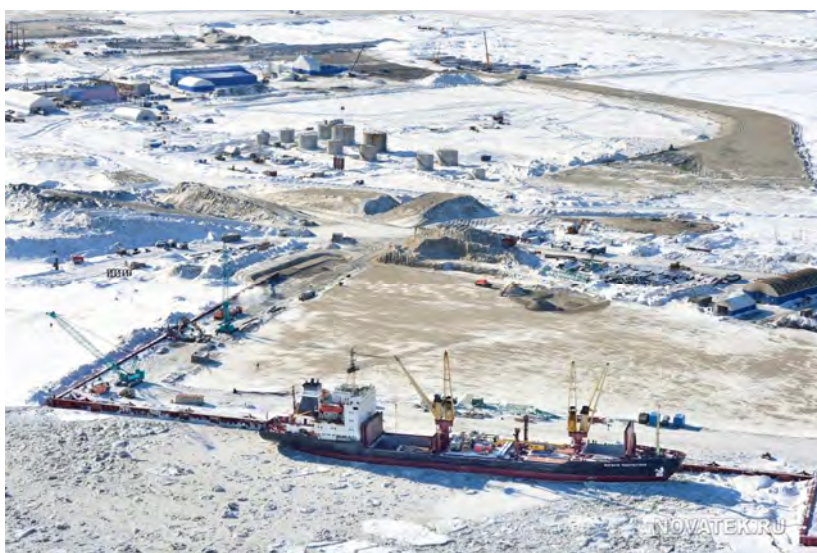
図-2.17 サベッタ港建設風景 26
