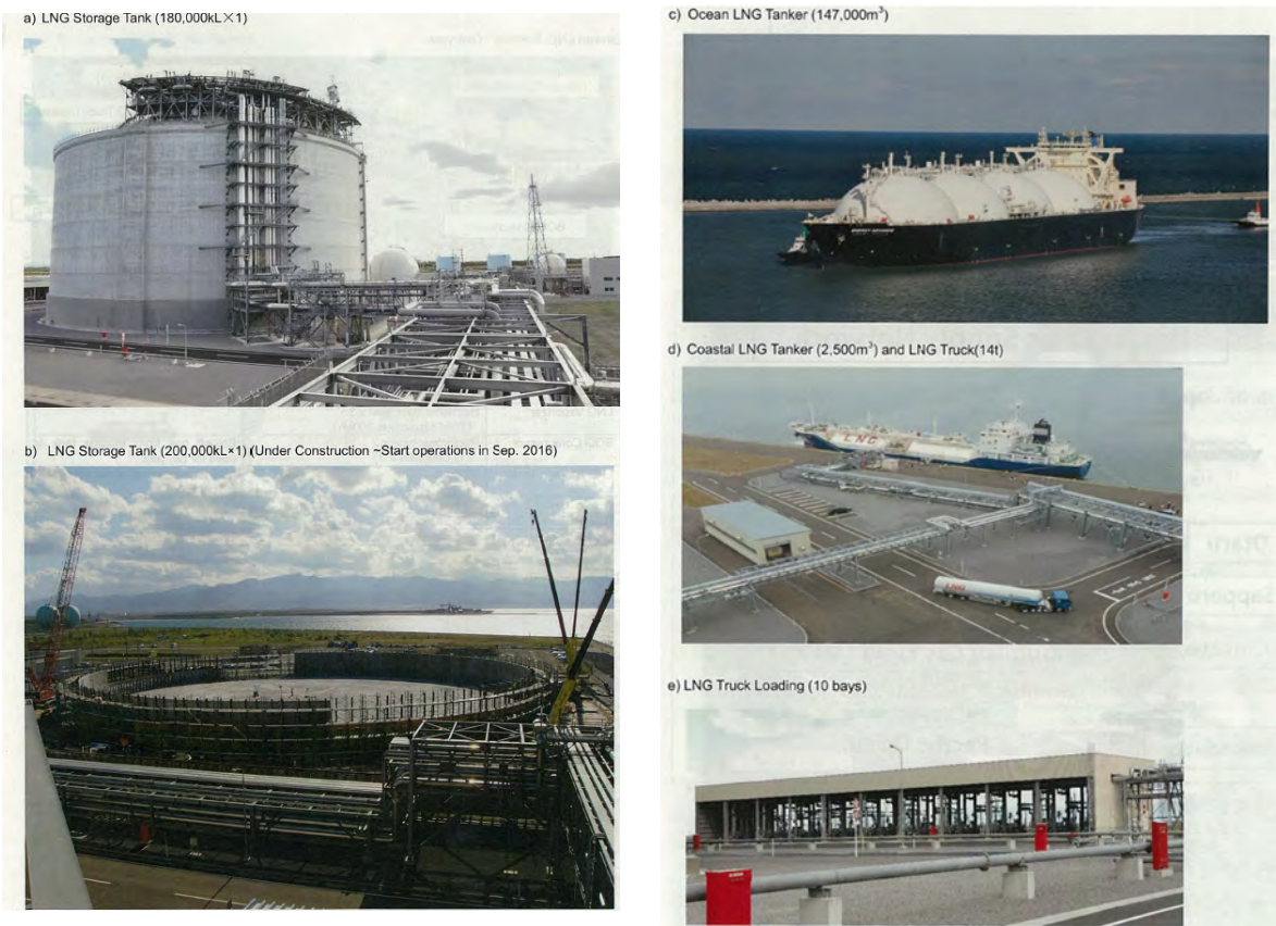
图-6.4 石狩 LNG 基地概要-3
