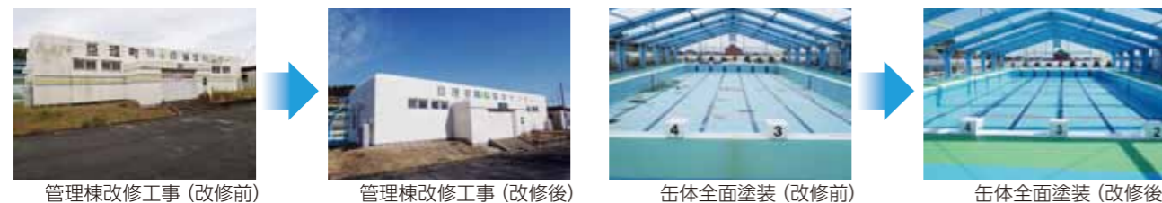
管理棟改修工事 (改修前) 管理棟改修工事 (改修後) 缶体全面塗装 (改修前) 缶体全面塗装 (改修後)
