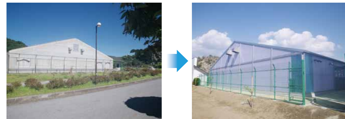
屋根固定化 (改修前) 屋根固定化 (改修後)
