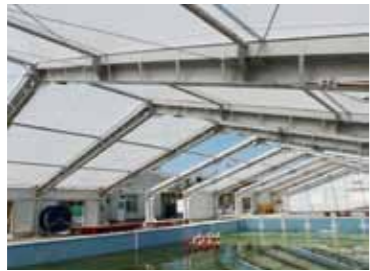
上屋シート (改修前)
