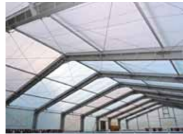
上屋シート (改修後)
