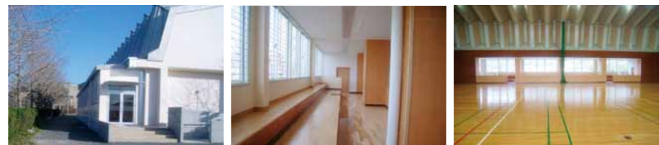
観覧者用入口を独立させ、観覧席からアリーナを通らずに使用できるトイレも新たに設置し、お互いの利用が制限されない造りになった。
