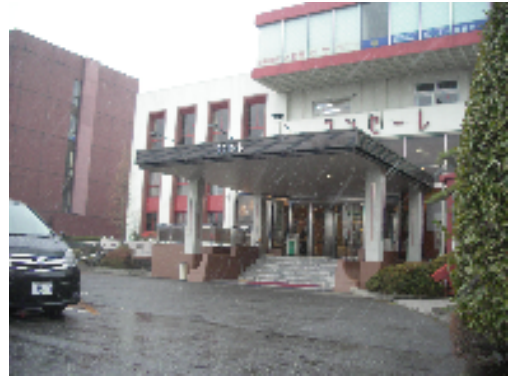
完成引渡後の現況写真(庇 & スロープ
