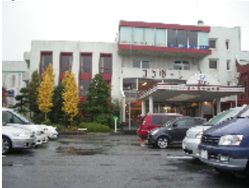
工事前の現況写真 庭園と庇(右側)
