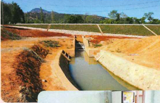
堰から各所へ配水する水門が完成
